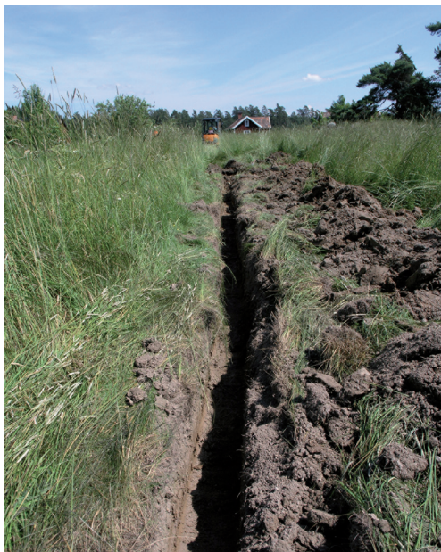
Figur 5. Kabelschaktet sett från väster. Foto: Maud Emanuelsson.
