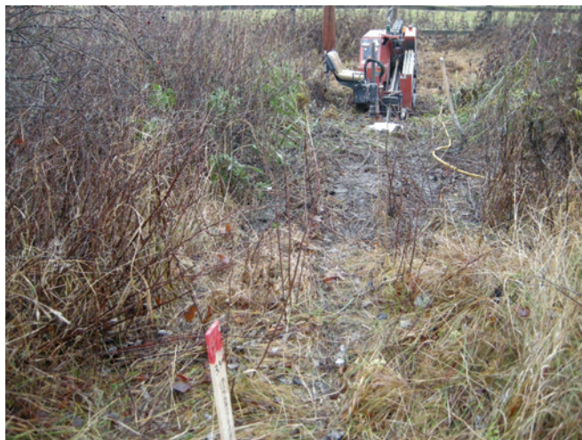
Bild 3. Tryckningen utfördes med en "Ditch Witch". Foto: Boel Melin
