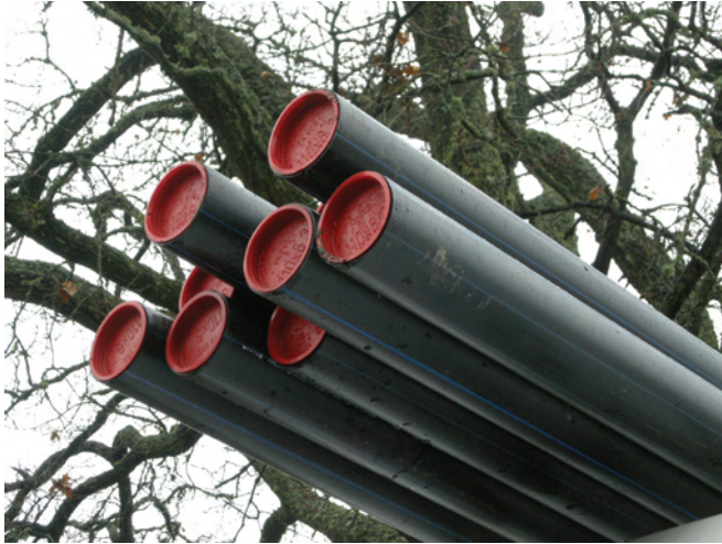
Bild 10. Rödragningen av plast som dras tillbaka genom den befintliga borrhningen under kanalen. Foto: Boel Melin.
