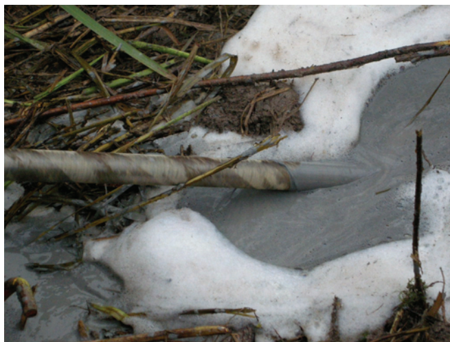
Bild 8. Ingångshålet för borren. Bilden visar rören i fjäderstål samt blålera som kommer upp genom borrhålet. Foto: Boel Melin.
