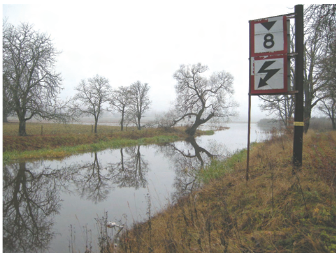
Bild 2. Kanalen mot norr. Foto: Boel Melin.
