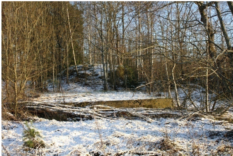
Figur 5. Gustavslätt. I förgrunden grunden till en ekonomibyggnad. I bakgrunden en jordkällare. Bilden är tagen från väst. Foto: Jan Åhlström.
