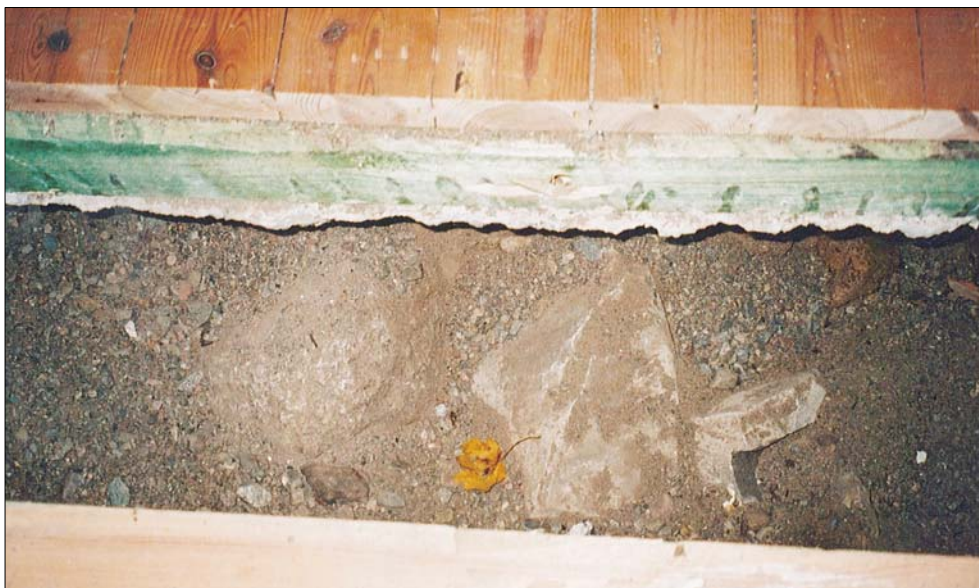
Figur 16. Möjliga syllstenar under trögolvet i det norra kabelschaktet. (Bild U. Alström.)
