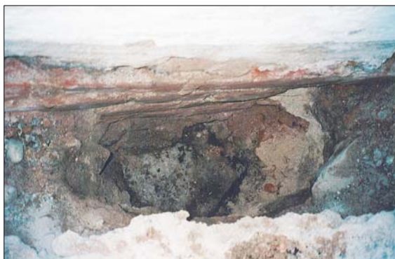
Figur 14. Schaktet vid den norra pelaren där särskilt tegelfundamentet från 1427 visar att pelarna liksom efter 1966 var fyrkantiga. (Foto U. Alström.)
