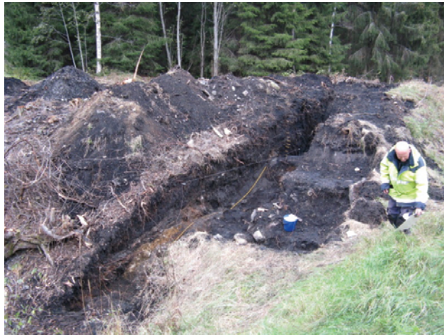
Figur 7b. I schakt 1 framkom delar av en masugn och tjocka kol- och sotlager. Topografien sluttar ned mot bäcken. Fotografiet från sydöst av Jan Åhlström.
