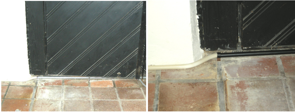
T.v. Bild 40. Eldragning täckt med blylist under porten i vapenhus före inmålning. Foto Boel Melin. T.h. Bild 41. Efter inmålning. Foto Boel Melin.
