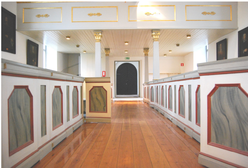
Bild 35. Mittgången mot vapenhuset. Golvet i mittgången lämnades delvis utan åtgärd. Man ser även läktarbarriär, taket under läktare samt bänkskärmar efter åtgärder. Foto: Boel Melin.
