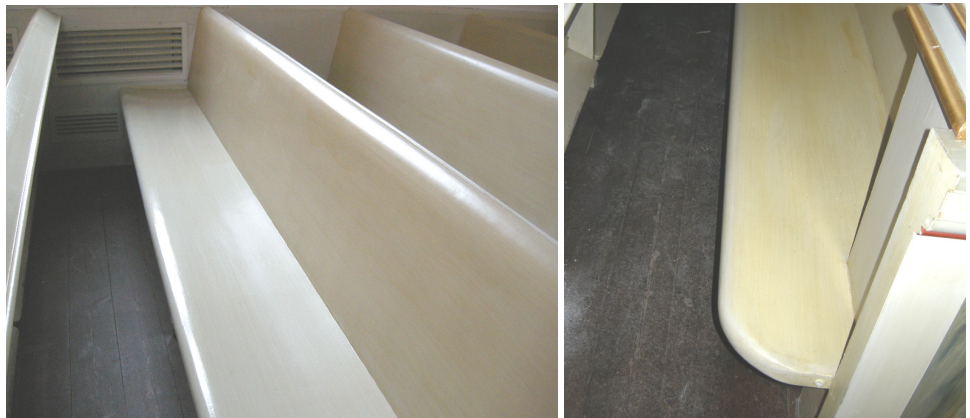
T.v. Bild 46. Bänkkvarterens sitt- och ryggbänkar och psalmbokshyllor rengjordes och bättringsmålades i en kulör som efterliknade den gulnande fernissan från 1980-talet. Bilden tagen efter åtgärder. Foto: Boel Melin.
