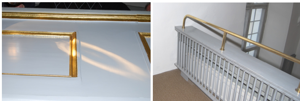
T.v. Bild 53. Läktarbarriärens målade ytor ommålades, medan förgyllningarna endast rengjordes. Bilden tagen efter åtgärd. Foto: Boel Melin.
