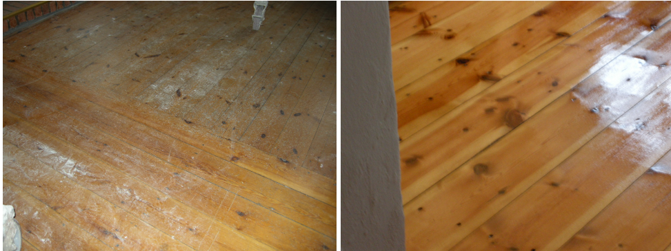
T.v. Bild 33. Långhusets trägolv innan åtgärd. Foto: Boel Melin.
