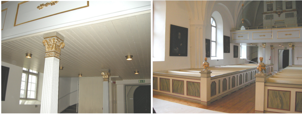
T.v. Bild 20. Läktarunderbyggnad efter rengöring. Foto: Boel Melin.
