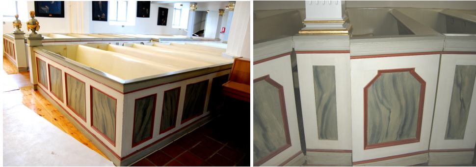
T.v. Bild 44. Bänkskärmarnas speglar och ramverk rengjordes och retuscherades i viss mån. Foto: Boel Melin.
