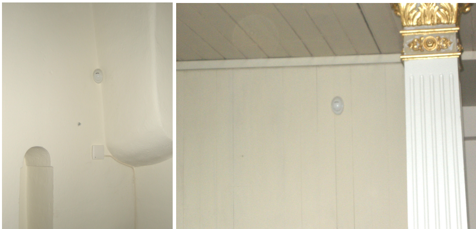
T.v. Bild 42. Larmdetektor i vapenhuset. Foto: Boel Melin. T.h. Bild 43. Detektor under läktare. Foto: Boel Melin.
