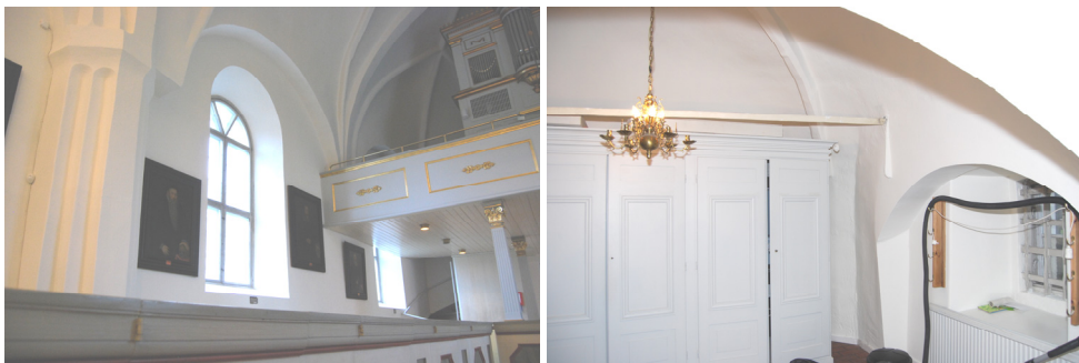
T.v. Bild 24. Del av södra väggen samt läktare efter åtgärder. Foto: Boel Melin.
