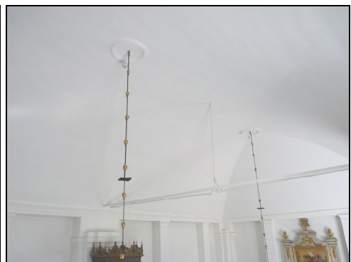
T.v. Bild 24. Rökdetektorn monterades genom det befintliga ljusarmshålet. Foto: Boel Melin.
