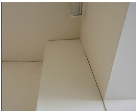
T.v. Bild 21. Håltagning upp mot läktare, innan låda. Foto: Boel Melin.
