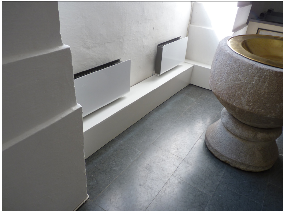
Bild 14. Ny sockellist vid södra korväggen. Radiatorerna flyttades uppåt en bit för att ge plats åt sockeln. Foto: Boel Melin.
