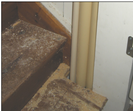
T.v. Bild 19. Ett hål togs upp i läktartrappans nedersta trappsteg för att ge plats åt kabeldragning upp till läktaren. Foto: Boel Melin.
