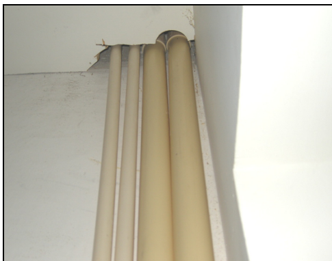
T.v. Bild 21. Håltagning upp mot läktare, innan låda. Foto: Boel Melin.
