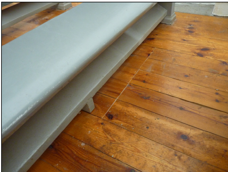
Bild 11. Inspektionslucka under de södra bänkkvarteren. Foto: Boel Melin.
