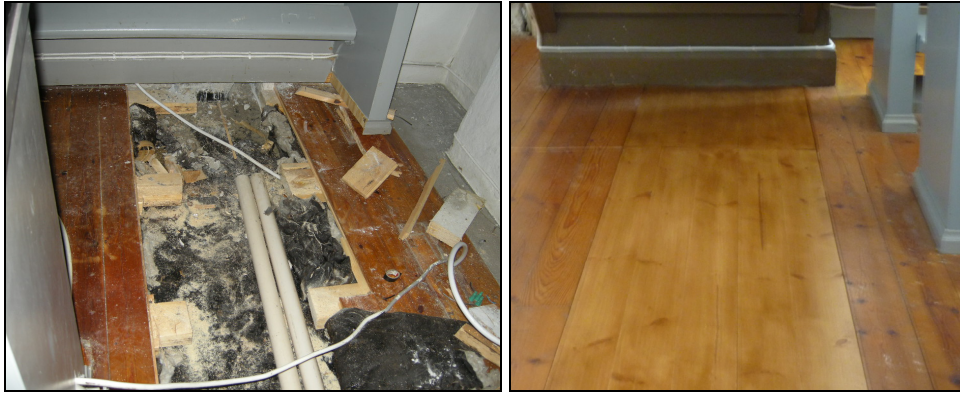
T.v. Bild 7. Kabeldragning under predikstolen. Foto: Boel Melin.
