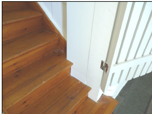
T.v. Bild 19. Ett hål togs upp i läktartrappans nedersta trappsteg för att ge plats åt kabeldragning upp till läktaren. Foto: Boel Melin.
