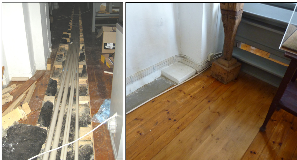
T.v. Bild 5. Plankorna har tagits upp och kabeldragningen lagd i rör i luftspalten. Södra långhuset. Foto: Boel Melin.
