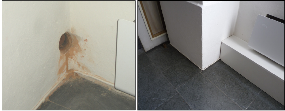
T.v. Bild 12. Håltagning i valpelare från 1751–53, södra korväggen. Foto: Boel Melin.
