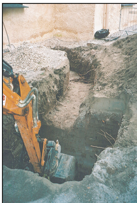
Figur 6. Schaktet från tornets sydvägg fram till pumpgropan. Pumpgropan är 1,8 \times 2 m stor och 2 m djup dvs långt djupare än benförande lager. (Foto U. Alström.)
