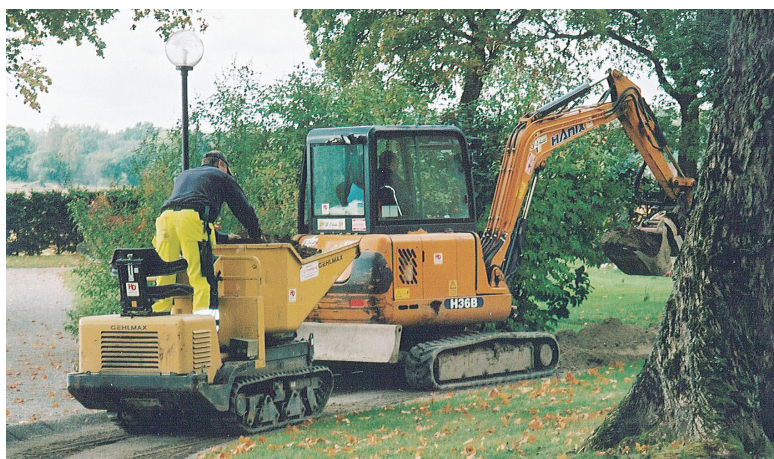
Figur 4. Schaktningarna på kyrkogården utfördes med mindre maskiner som skonade kyrkogårdsmiljön. (Foto U. Alström.)
