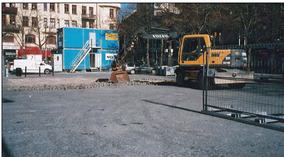
Figur 2. Nordvästra delen av Järntorget där arbetet med omdaning av torget just börjat. (Foto U. Alstöm.)
