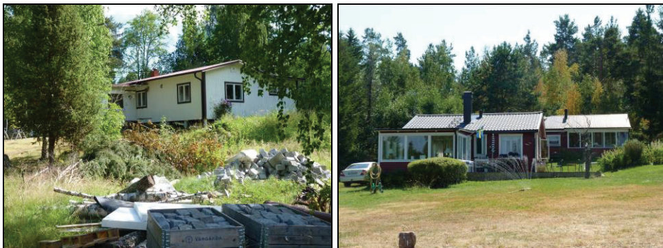
Figur 39. Stuga som började uppföras 1953 - 54 med en kiosk som grundmaterial. Därefter har stugan byggts om och till vid ett flertal tillfällen. Foto: Helén Sjökvist.
