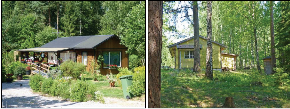
Figur 44. Stuga av 1970-tals typ med flackat sadeltak och laserad panel samt stora fönster. Foto: Helén Sjökvist.
