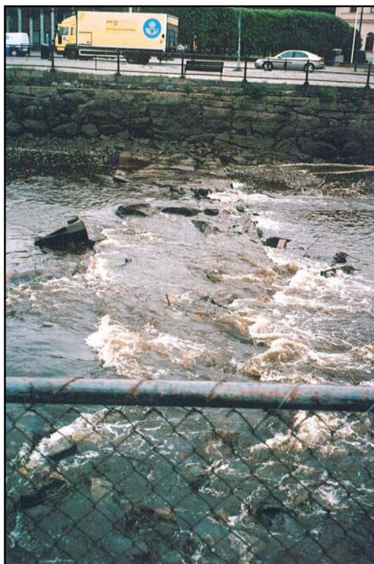
Figur 4. Vid lågt vatten framträder kvarndammen som byggdes tvärs över Svartån för att ge vattenkraft till Wickholms kvarn. Det är rimligt att anta att dammvallen är lika gammal som kvarnen, (Foto från väster U. Alström.)
