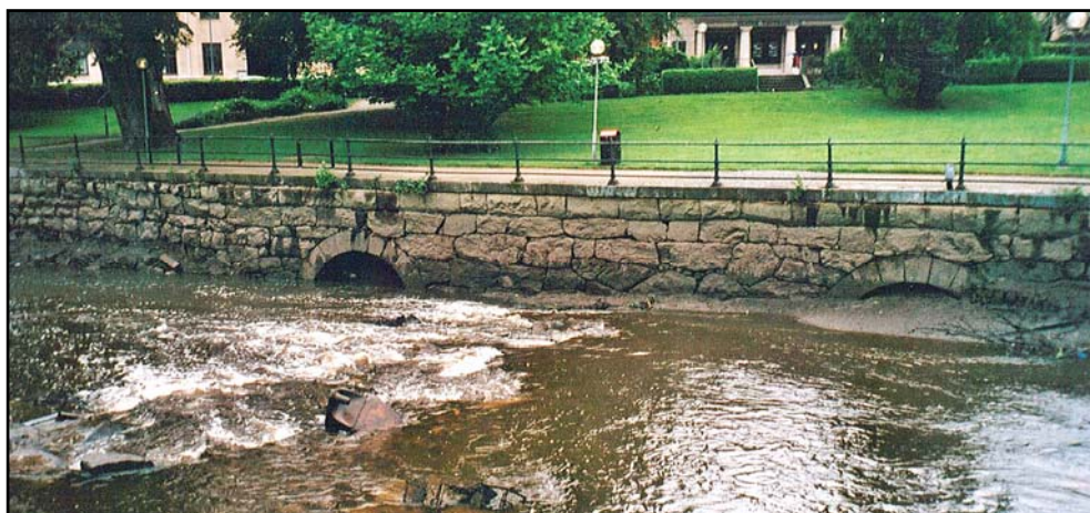
Figur 2. In- och utflödet till Wickholms kvarn avtecknar sig i stenskoningen i form av valvbågar. (Foto från nordöst Ulf Alström 2009.)
