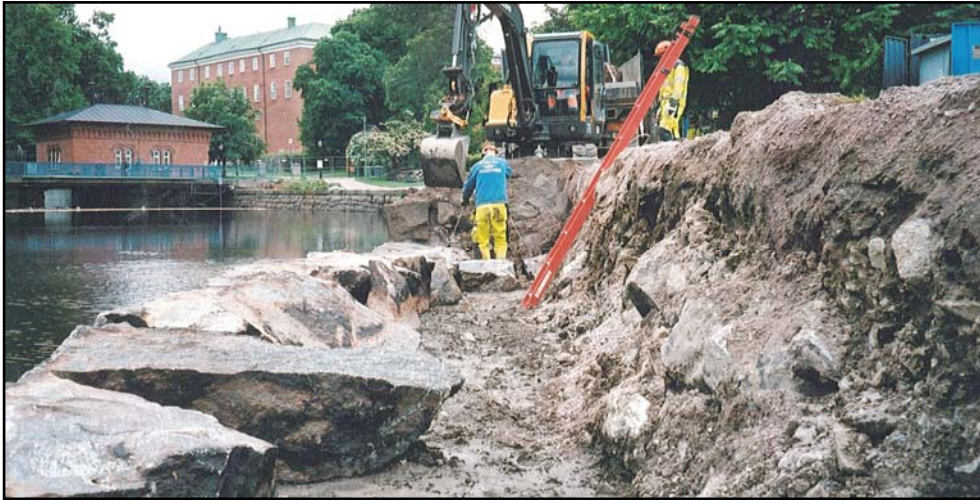
Figur 8. Murens insida var delvis ganska ojämn. Fyllnadsmassorna bestod av sten, grus, jord och tegel. På bilden syns det tredje varvet av stenskoningen. (Foto från norr U. Alström.)
