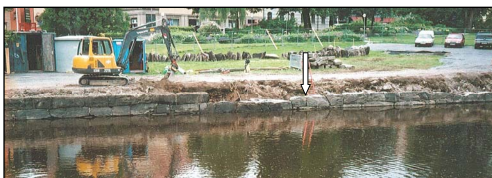
Figur 6,7 Stenskoningen under demontering. Kvarnens vattenkanal påverkades inte av arbetet. Följdriktigt finns även valven kvar efter grävarbetet. Inloppet markerat med pil. (Foto från öster U. Alström)
