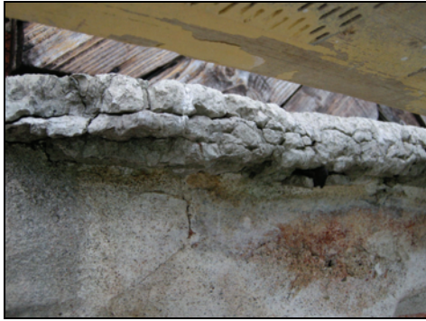
T.v. Bild 20. Skador på solbänk under ljudlucka. Foto: Anna Gütblein.
