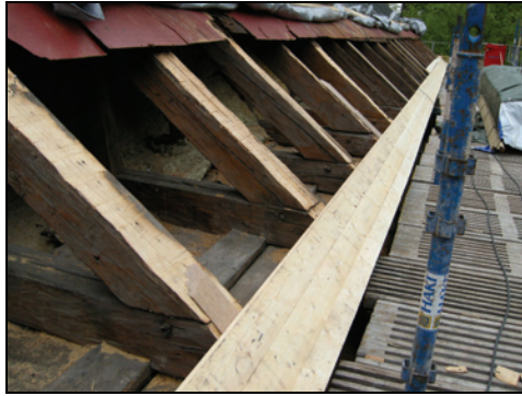
T.v. Bild 4. Gammal underbrädning togs delvis bort. Bilden visar ny underbrädning i nederkant samt de äldre boardskivorna som låg mellan underbrädning och plåt. Foto: Boel Melin.
