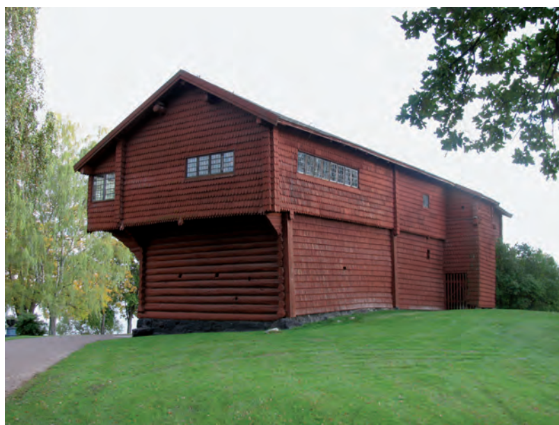
Fig. 14. Det statliga byggnadsminnet Ornäsloftet i Torsångers socken, som är så intimt förknippat med berättelserna om Gustav Vasa. Foto: Ronnie Jensen 2010.
