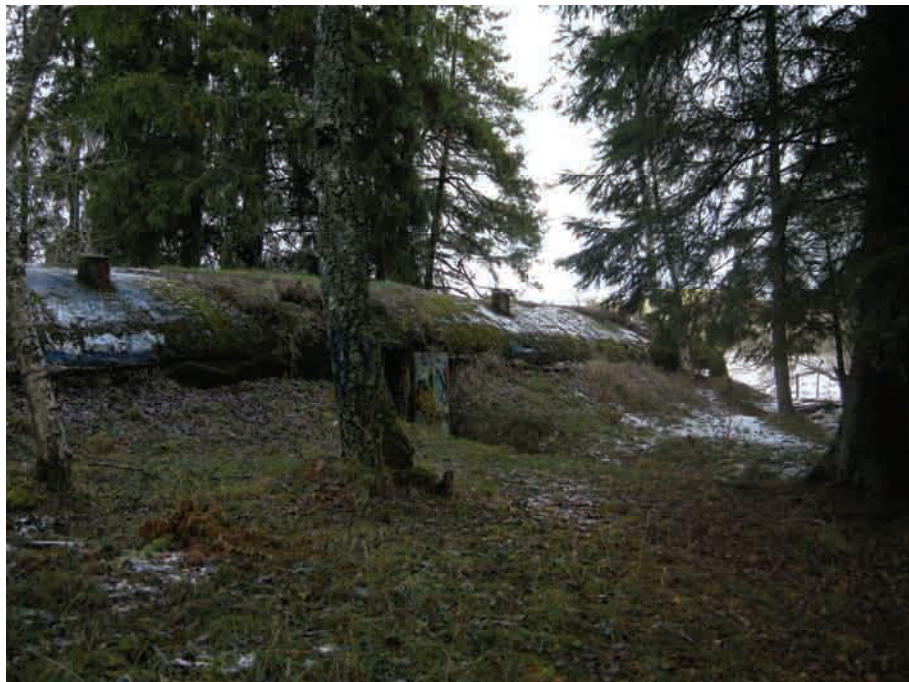
Figur 6. Bunkern Täby 443:1 från sydväst. Foto Jan Åhlström.
