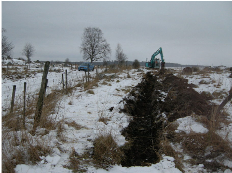
Figur 6. Schaktet vid Berga från väster. Foto Jan Ählström.
