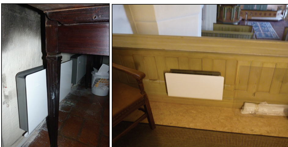
T.v. Bild 22. Nya elradiatorer i sakristian. Bilden visar hur den tidigare radiatoren orsakat nedsmutsning av ovanliggande väggyta. Foto: Boel Melin.
