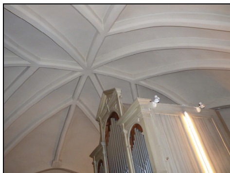
T.v. Bild 9. Att borra hål för en hissbar rökdetektor i stjärnvalvets slutsten var ett för stort ingrepp ur antikvarisk synvinkel. Foto: Boel Melin.
