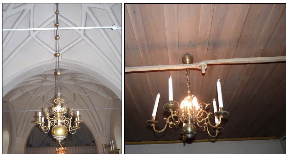
Bild 2 och 3. Dragjärn som till stora delar är från 1600-talet förekommer i kyrkorummet och i sakristian. Foto: Boel Melin.
