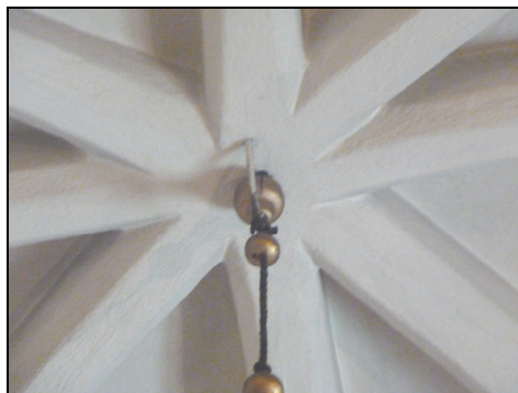
T.v. Bild 7. Det fanns befintlig håltagning i korets stjärnvalv. Foto: Boel Melin.
