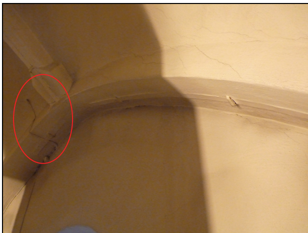
T.v. Bild 14. Gördelbågen bakom orgeln mot västra väggen. Röd ring visar befintlig håltagning genom valvkappa. Foto: Boel Melin.
