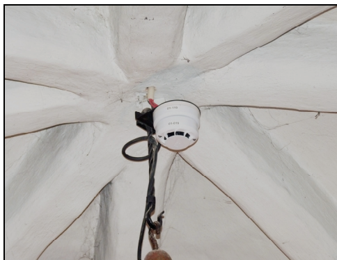
T.v. Bild 12. IR-detektor och brandvarnare monterades på sakristians södra vägg och takyta. Foto: Boel Melin.
