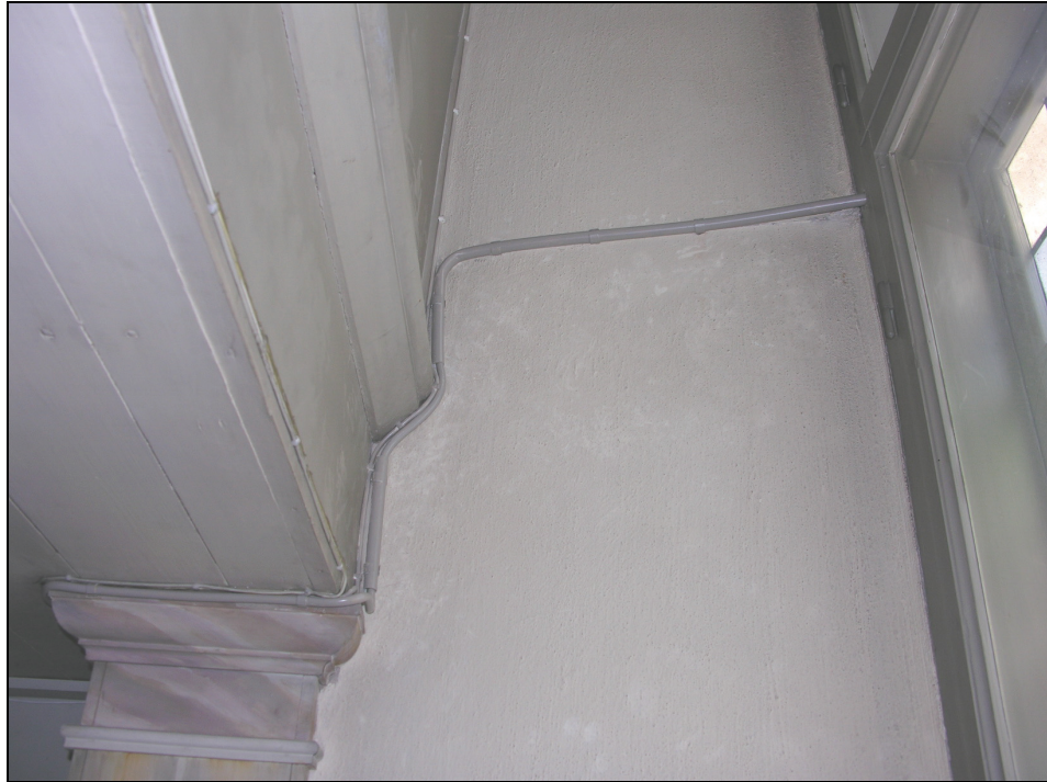
Bild 6. Bilden visar fönstersmyg på kyrksalens norra sida, bakom läktaren. Kabel drogs genom befintlig håltagning i fönsterkarm. Eldragningen målades in i kulör liknande läktartaketets panel. Foto: Sören Andersson.
