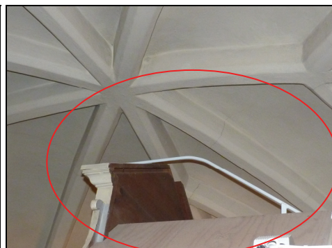
T.v. Bild 9. Att borra hål för en hissbar rökdetektor i stjärnvalvets slutsten var ett för stort ingrepp ur antikvarisk synvinkel. Foto: Boel Melin.
