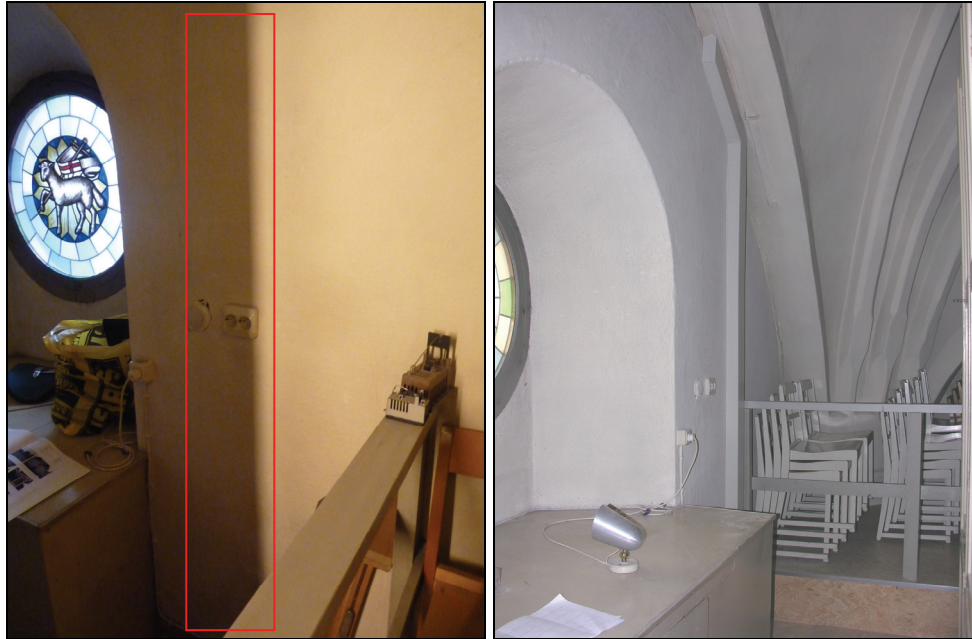
T.v. Bild 16. Väggyta bakom orgeln, nedanför gördelbåge, innan kablagelådan monterades. Röd markering visar placering av befintlig uppbyggd kabelkanal. Foto: Boel Melin.
