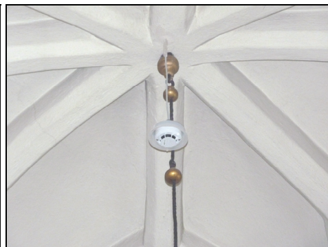
T.v. Bild 7. Det fanns befintlig håltagning i korets stjärnvalv. Foto: Boel Melin.
