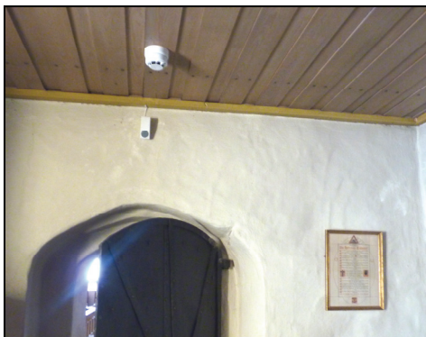
T.v. Bild 12. IR-detektor och brandvarnare monterades på sakristians södra vägg och takyta. Foto: Boel Melin.
