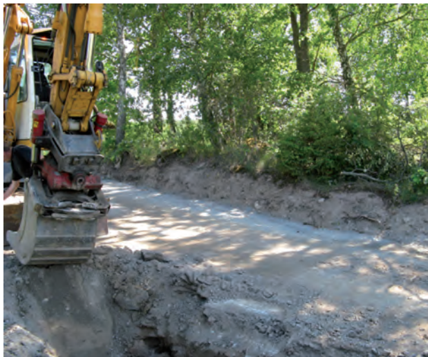
Figur 38 (ovan till vänster). Schaktning i befintlig väg intill fornlämning Kärabo 102:2. Fotograferat från sydväst av Anna-Lena Hallgren.
