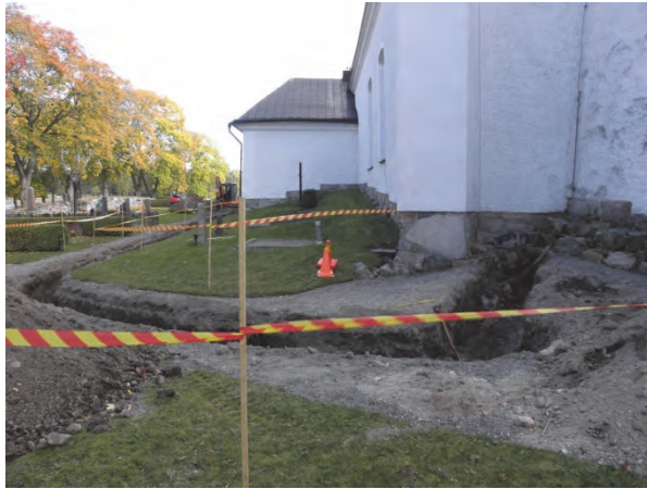
Figur 16. Schaktet gick från salkyrkans västra mur och sträckte sig norr om kyrkan. Till höger ses delar av västtornet. Fotograferat från väster av Jonas Ros.
