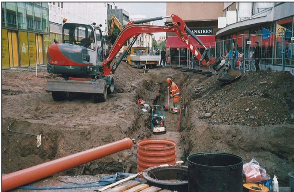
Figur 5. Smedjegatan under ombyggnad hösten 2010. Bilden visar Smedjegatan mot öster mellan kvarteren Igor och Klas. Föremålen i förgrunden ligger på en utskjutande del av varutunnelns tak. (Foto U. Alström).
