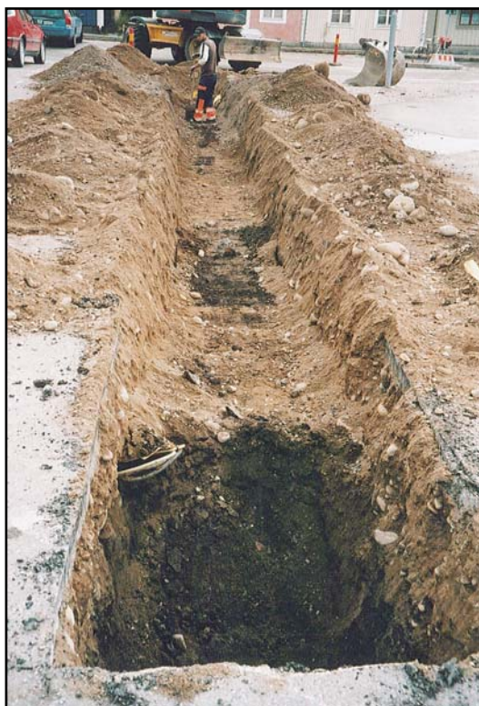
Figur 8. Det norra ledningschaktet på Fredstorget. Från gropen närmast i bild ritades en profil (fig. 6). I övrigt påverkades endast ett sentida bärlager. (Foto från väster U. Alström).
