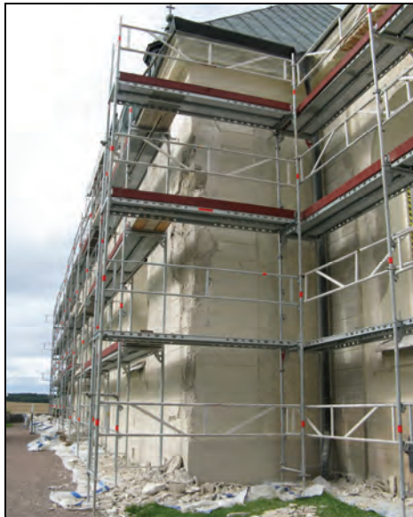
T.v. Bild 32. Pågående puts slagning på korets slätputsade fasad. Foto: Boel Melin.
