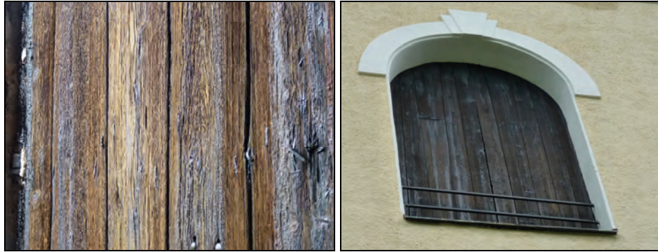
T.v. Bild 58. Ljudlucka innan tjärning. Foto: Boel Melin.
