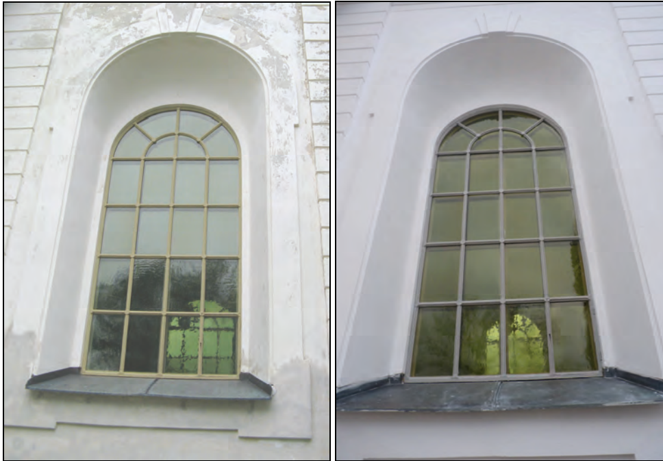
T.v. Bild 54. Gjutjärnsfönster på långbus innan renoveringen. Bågarna var målade i en gul kulör. Foto: Boel Melin.
