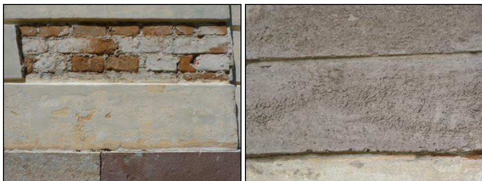
T.v. Bild 28. Putsläpp på rusticerad lisen på koret. Foto: Helén Sjökvist.
