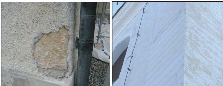
T.v. Bild 22. Putsbortfall vid sakristians hörn visar tydligt det yttersta tjocka pustpåslaget. Foto: Boel Melin.
