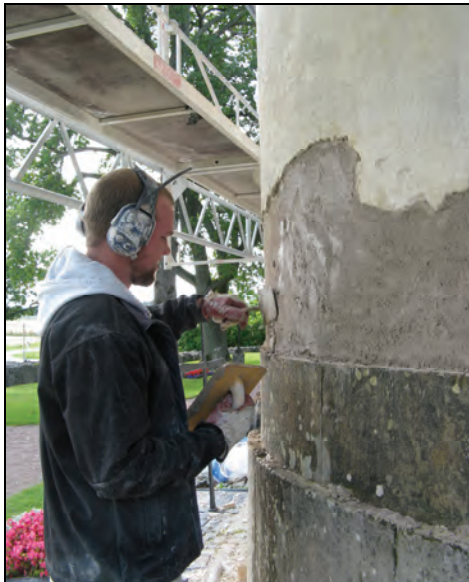
T.v. Bild 32. Pågående puts slagning på korets slätputsade fasad. Foto: Boel Melin.
