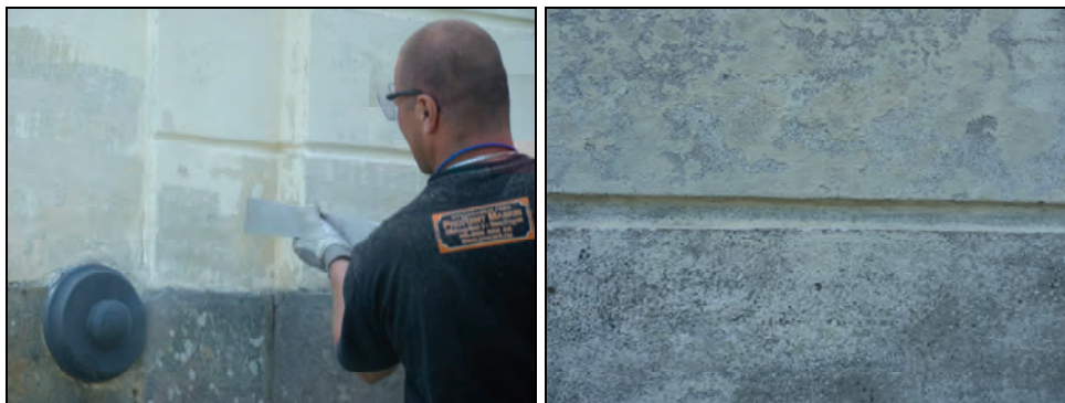
T.v. Bild 12. Under pågående isblästring på koret. Foto: Boel Melin.
