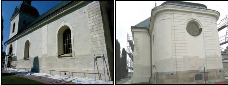
T.v. Bild 16. Nedre delen av södra långbusfasaden samt hörnkedjan närmast i bild har på bilden isblästrats. Foto: Helén Sjökvist.
