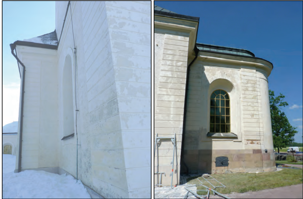
T.v. Bild 24. Tornets nordvästra hörn. Bilden visar färgsläpp och synliga stenar i spritsputsen. Foto: Boel Melin.
