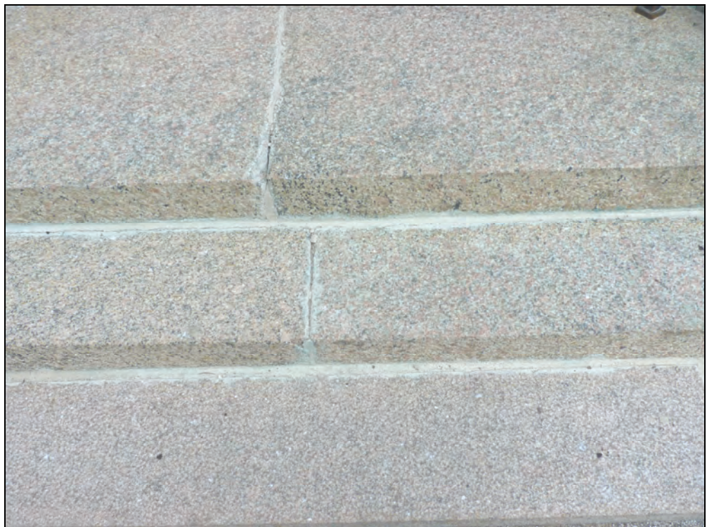
Bild 60. Nyfogad stentrappa vid västra tornentrén. Foto: Boel Melin.
