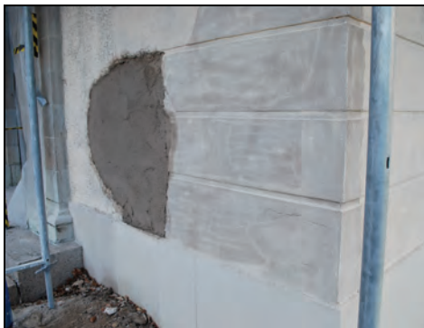
T.v. Bild 34. Puts slagning på torn. Foto: Boel Melin.
