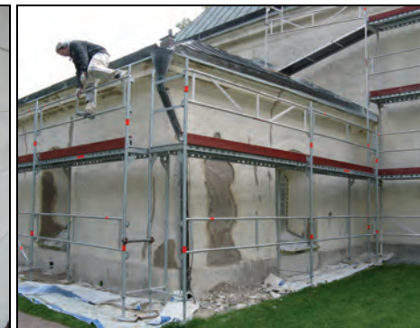
T.h. Bild 35. Sakristian under pågående puts slagning. Lagningar utfördes runt ömfattningar och på sprütputs. Foto: Helén Sjökvist.
