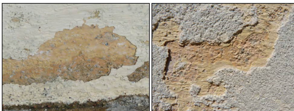
T.v. Bild 8. Flera olika gula nyanser förekom under dagens spritputs. Foto: Boel Melin.
