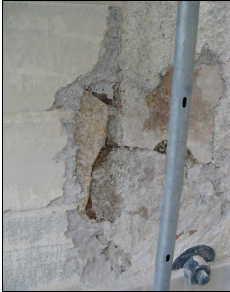
T.v. Bild 30. Putsbortfall vid sakristians östra dörrömfattning. Foto: Boel Melin.
