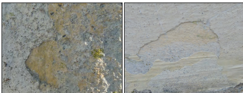
T.v. Bild 10. Synlig gul spritputs på långhus. Foto: Boel Melin.
