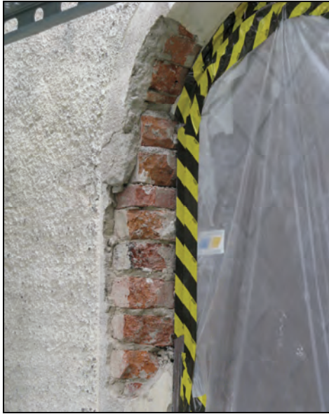
T.v. Bild 30. Putsbortfall vid sakristians östra dörrömfattning. Foto: Boel Melin.
