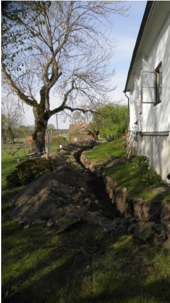
Figur 6. Fjärrvärmeschaktet vid södra flygeln, där lager 5 återfanns. Foto från öster.
