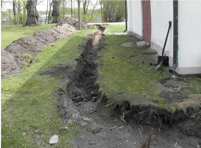
Figur 5. Fjärrvärmeschaktet, vid norra flygeln, med lager 4. Härden – A6 – befinner sig i bildens bakgrund, mitt emot bögen med orangea arbetskläder. Foto från norr.
