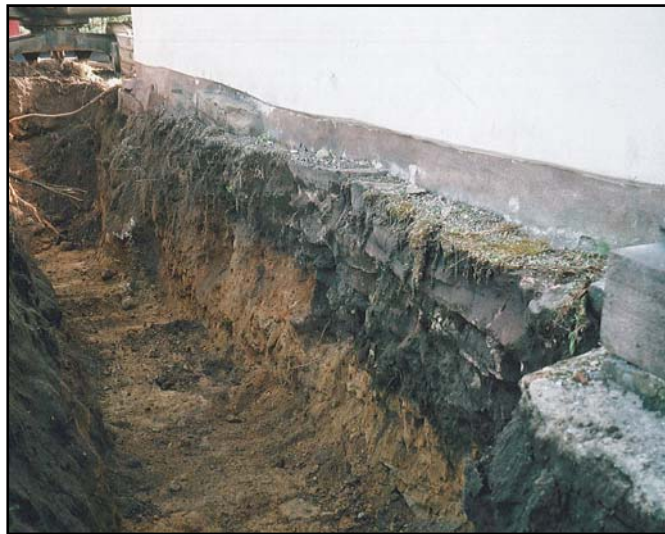
Figur 10. Även under sakristians norra mur avtecknade sig en nergrävning i den hårda moränen (foto från NV U. Alström).
