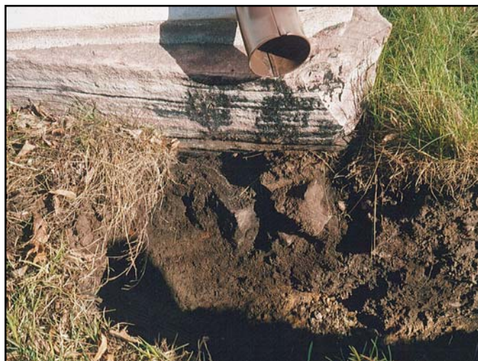
Figur 11. Grundläggningsstenar under korets sydöstra hörn. (Foto U. Alström).
