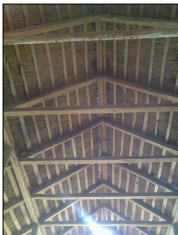
Figur 3. Takstolskonstruktion. Foto: Ove Tunbielm.
