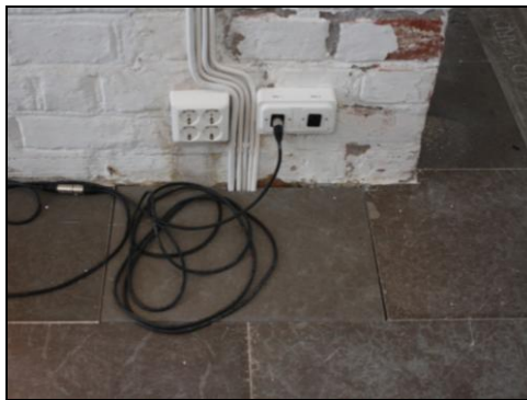
T.v. Bild 39. Ett dubbelt mikrofonurtag installerades i koret som en del i den nya ljudanläggningen i kyrkan. Foto: Boel Melin.
