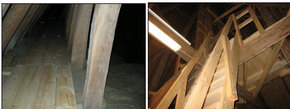
T.v. Bild 34. Ny gångbrygga invid takfall. Foto: Anna Gütblein
