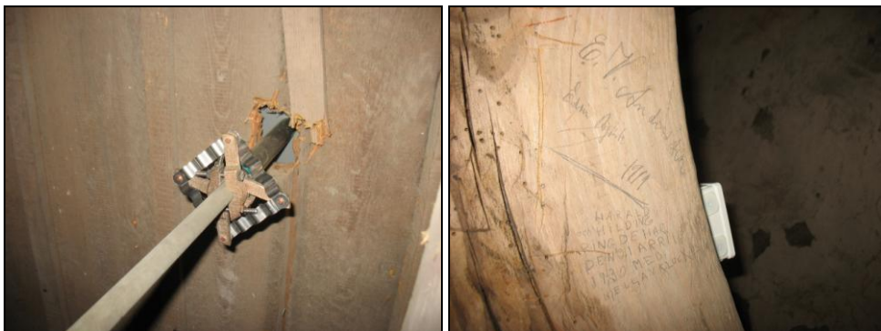
T.v. Bild 54. Rör till urverk som går genom väggen i utrymmet. Röret kapades och skarvades med ett nytt rör som monterades till det nya urverket. Foto: Boel Melin.
