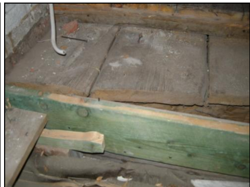
T.v. Bild 15. Äldre underliggande brädgolv, troligen från tidigt 1700-tal, förkom under befintligt golv på läktaren. Foto: Boel Melin.
