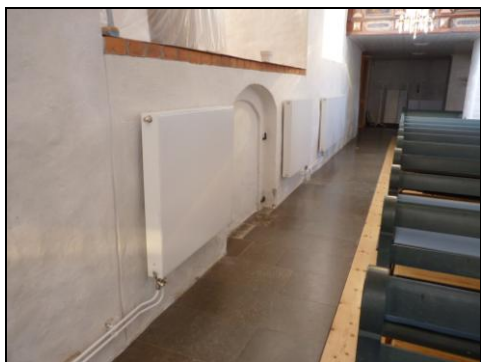
T.v. Bild 41. Södra långväggen med de nya panelradiatorerna. Foto: Boel Melin.
