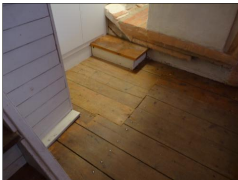
Bild 25. Ny lucka i golvet på södra läktaren, vid vindsuppgång. Foto: Boel Melin.
