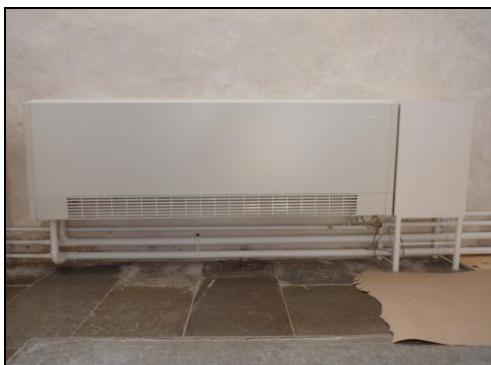
Bild 36. Nytt fläktelement i koret mot söder. Foto: Boel Melin.
