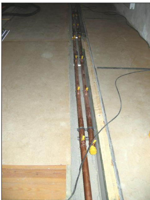
Bild 10. Kopparrör i betongkanal. Kyrkorummet. Foto: Boel Melin.
