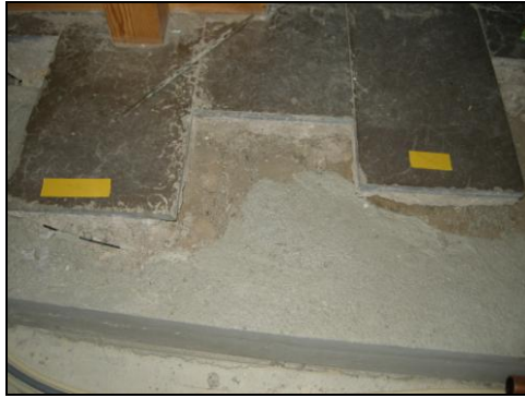
T.v. Bild 11. Vid upptagningen av kalkstensplattor skadades flera av dem. Gula markeringar visar stenar som skall bytas ut. Foto: Boel Melin.
