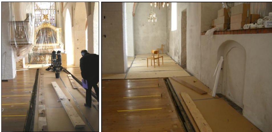
T.v. Bild 8. Mittgång och trägolv under bänkkvarter. Bilden visar de två kanalerna på varsin sida av mittgången. Dessa doldes senare av den breddade träfrisen. Foto: Anna Gütblein.
