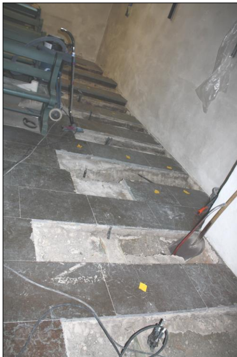
T.v. Bild 13. Kalkstengolvet under arbete, skadade delar markerade med gult. Foto: Boel Melin.
