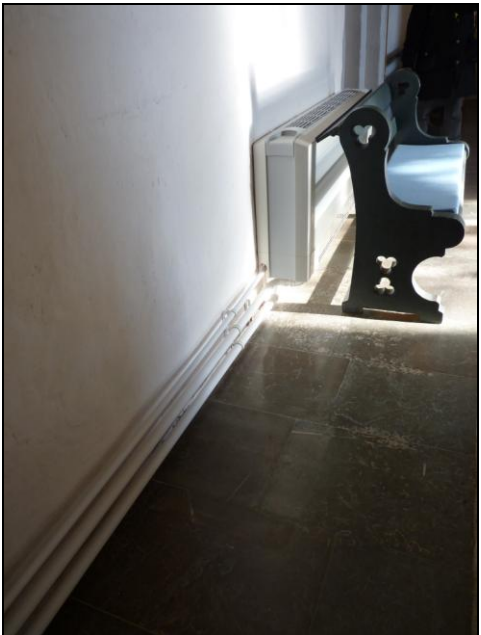
T.v. Bild 45. Ny rördragning och kamfläktsradiator bakom altaret. Foto: Boel Melin.
