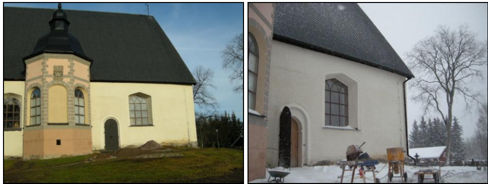
T.v. Bild 58. Långhusets södra takfall. Innan hängränna och stuprör monterades. Foto: Boel Melin.
