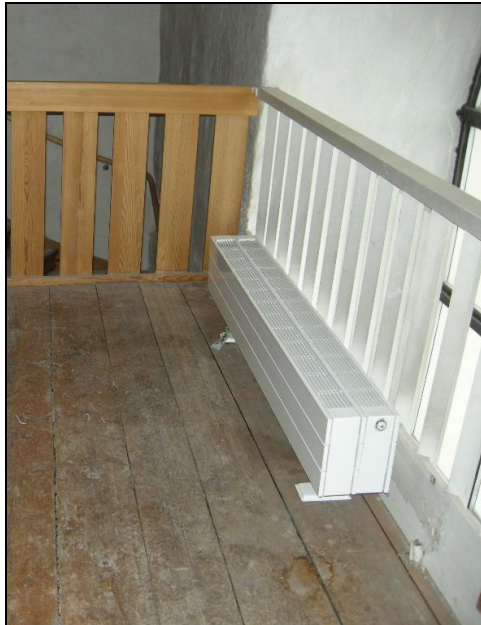
T.v. Bild 37. Fläktelement på norra läktaren. Foto: Boel Melin.
