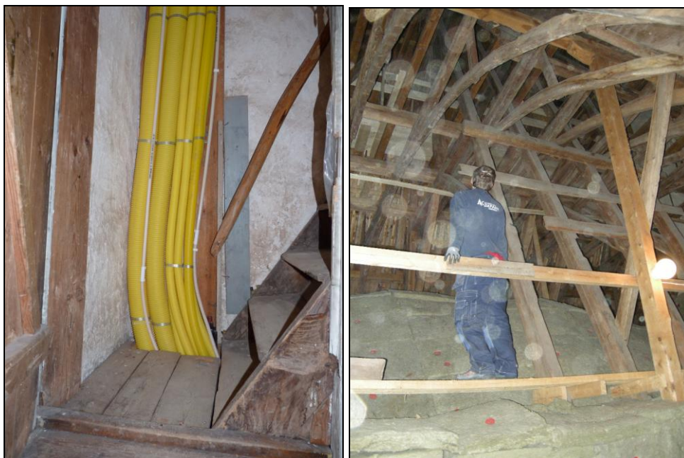
T.v. Bild 32. Ledningsdragning i kyrkvindstrappan. Foto: Boel Melin.
