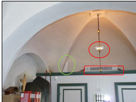
T.h. Bild 30. Sakristian. Ny halogenkrans samt ventilationsanläggning till toalett och städskrub. Grön ring markerar liten låda som döljer de nya rördragningarna. Foto: Boel Melin.
