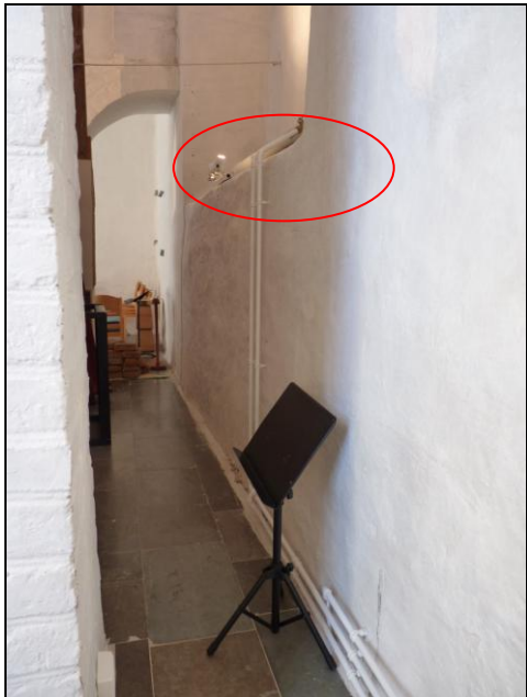
T.v. Bild 45. Ny rördragning och kamfläktsradiator bakom altaret. Foto: Boel Melin.
