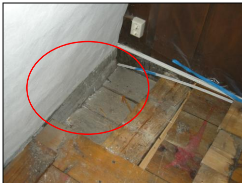
T.v. Bild 15. Äldre underliggande brädgolv, troligen från tidigt 1700-tal, förkom under befintligt golv på läktaren. Foto: Boel Melin.
