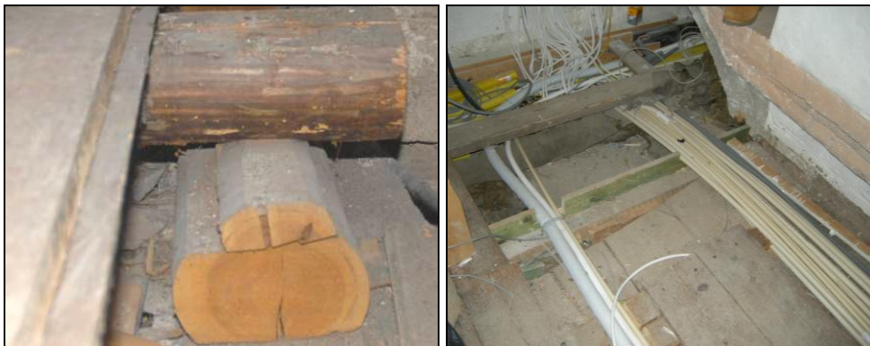
T.v. Bild 17. Äldre underliggande brädgolv, troligen från tidigt 1700-tal, förkom under befintligt golv på läktaren. Foto: Boel Melin.
