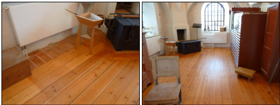
T.v. Bild 26. I sakristians trägolv sågades en inspektionslucka upp i trägolvet. Foto: Boel Melin.
