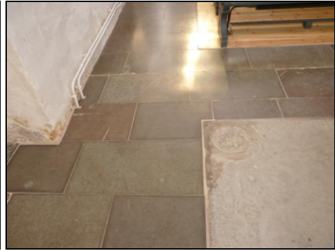
T.v. Bild 11. Vid upptagningen av kalkstensplattor skadades flera av dem. Gula markeringar visar stenar som skall bytas ut. Foto: Boel Melin.
