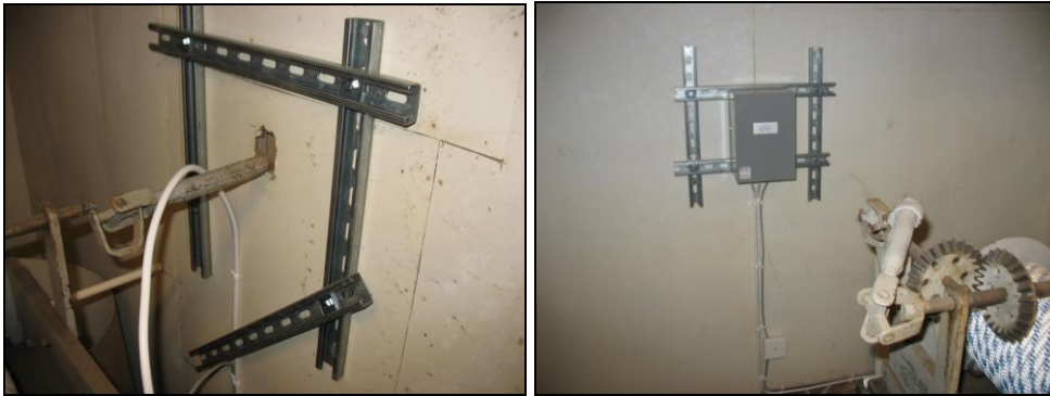
T.v. Bild 52. De nya motorverken monterades fast på stålskenor, fästa på utrymmets masonitväggar. Foto: Boel Melin.
