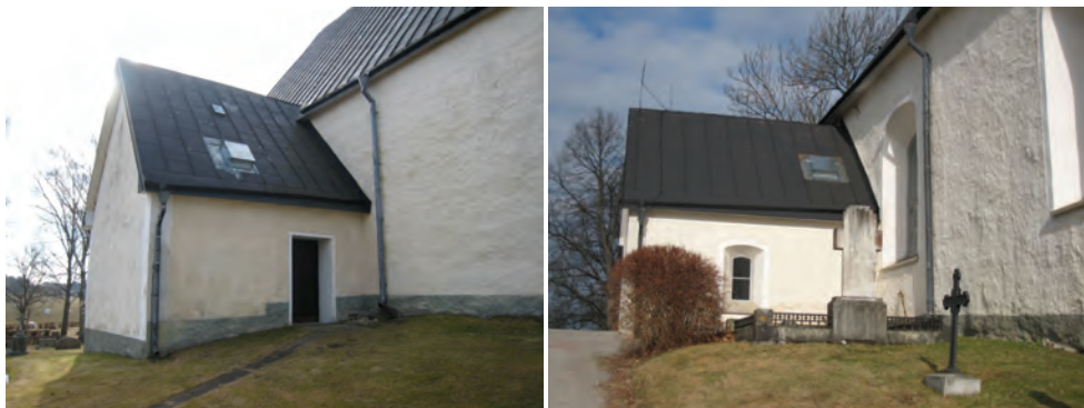
Figur 7. Sakristians västra takfall med taklucka som tidigare ej målats in. Foto: Helén Sjökvist.
