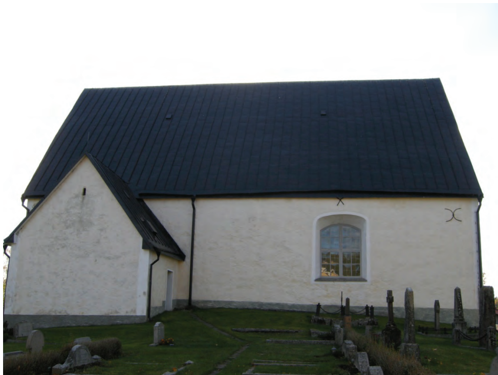
Figur 9. Norra takfallet efter målningsåtgärder. Också stuprören har målats. Foto: Helén Sjökvist.
