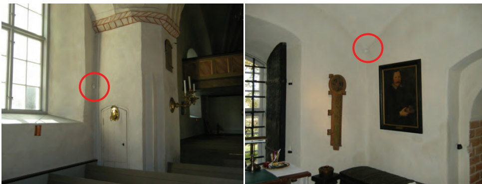
Figur 4. Detektor på södra långhusväggen. Foto: Helén Sjökvist.
