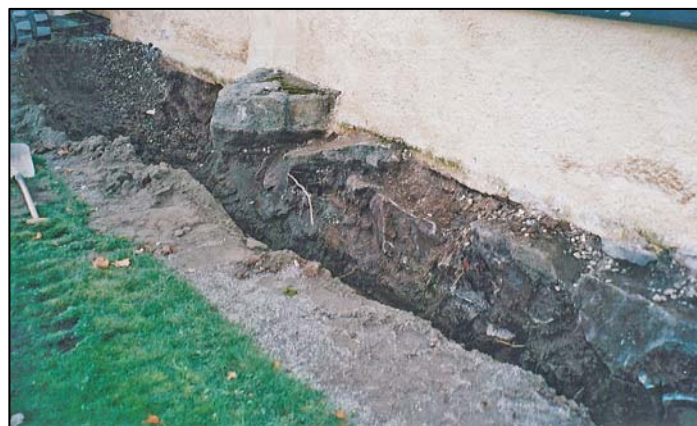
Figur 7. Detalj av kyrkans norra grundmur. Den större stenen tillhör fundamentet till en borttagen strävpelare. (Foto från nordväst U. Alström.)
