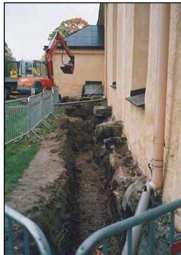
Figur 6. Schaktet norr om kyrkan grävdes i jord och lera varför schaktet fick det utseende som planerades. (Foto från väster U. Alström.)
