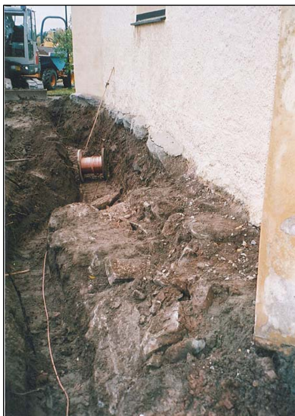
Figur 8. Den 3x1,6 m stora stenpackningen vid korets nordöstra hörn. (Foto från NÖ U. Alström.)
