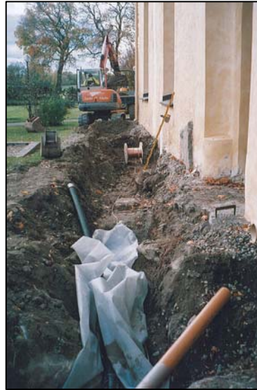
Figur 5. Det oregelbundna schaktet efter södra långhusmuren blev delvis bredare än planerat. På bilden syns också det svarta dräneringsröret, det rödaktiga dagvattenröret samt geotextilen som lades i botten av schaktet. (Foto från öster U. Alström.)
