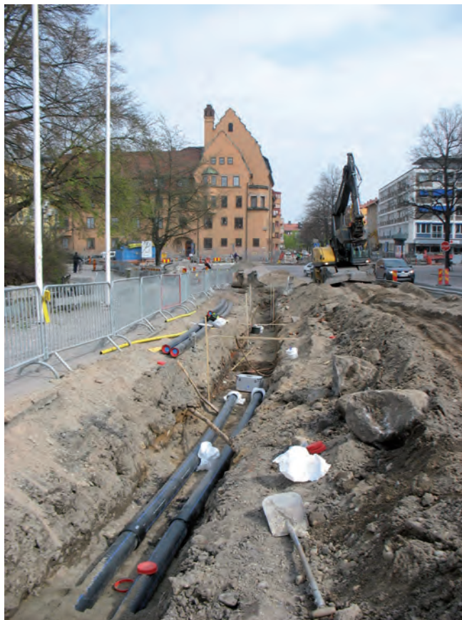
Figur 74. Schakt 2 i Biskopsgatan. Fotograferat från väster av Jonas Ros.
