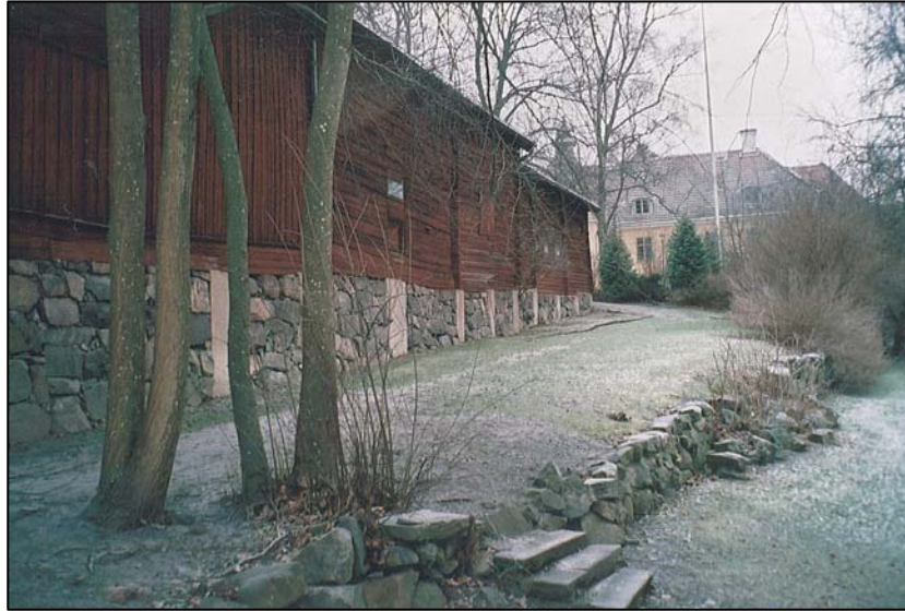
Figur 4. Bilden visar de nu stående röda knuttimrade husen efter Kyrkogatan från gårdsidan. De har en kraftigt uppbyggd grundläggning. Nedanför denna har det efter 1780-talet tillkommit ytterligare en terrassering som inte finns avbildad på teckningen (figur 3). Den lägre terrassen är uppfylld med matjord. (Foto från norr U. Alström.)
