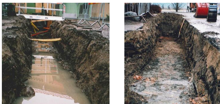
Figur 1. Bilden till vänster visar det NV-SÖ schaktet i kv. Sigvald. Bilden till höger visar det ÖNÖ-VSV schaktet i samma kvarter. De olika lagren som syns i schaktkanterna var påförda. Under dessa lager kom blåleran. (Foto U. Alström.)
