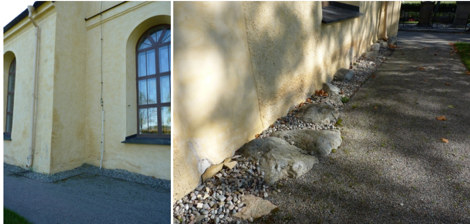
Figur 5. Kyrkans norra sida före åtgärder. Foto: Helén Sjökvist.
