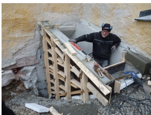
Figur 21. Ny källartrappa gjuts. Foto: Helén Sjökvist.
