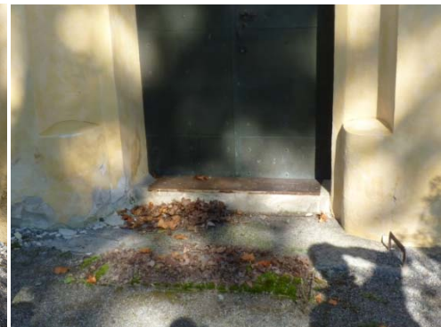
Figur 25. Under den befintliga rampen doldes en äldre stenbäll. Foto: Helén Sjökvist.
