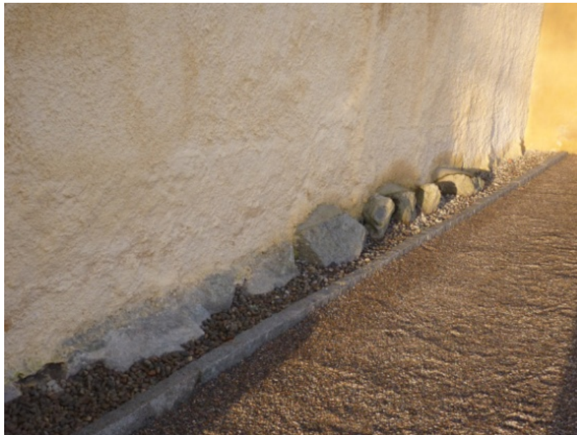
Figur 16. Korets östra sida efter åtgärder. Foto: Helén Sjökvist.
