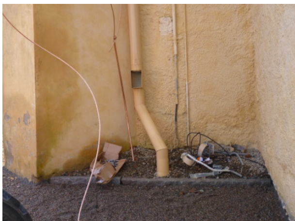
Figur 17. På korets norra sida fick stupröret anpassas efter grundens kraftigt utskjutande stenar under mark. Foto: Helén Sjökvist.
