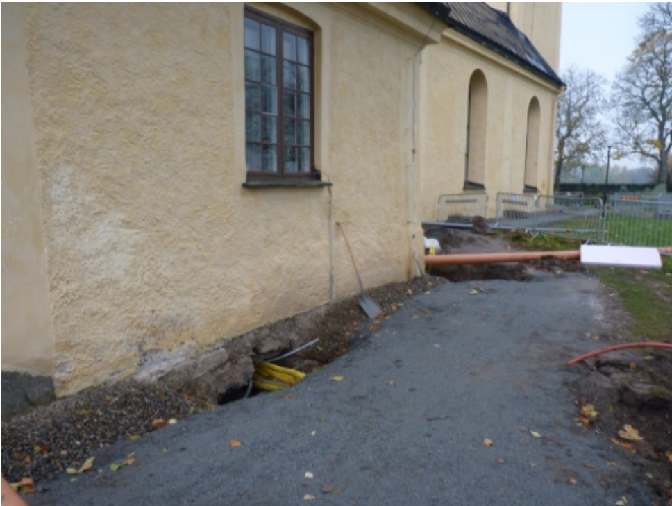
Figur 10. Nya eldragningar m.m. in till sakristians källare. Foto: Helén Sjökvist.
