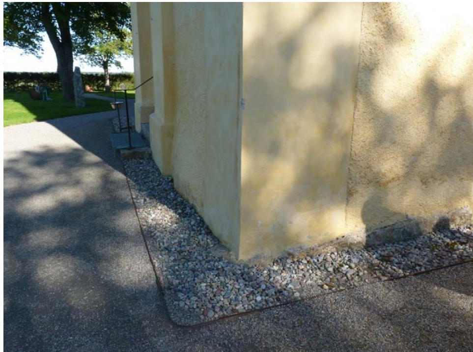
Figur 7. Tornets sydvästra hörn före åtgärder. Foto: Helén Sjökvist.
