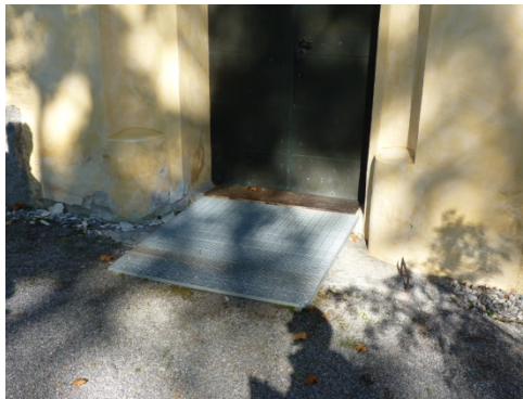
Figur 24. Tidigare ramp av stålaller. Foto: Helén Sjökvist.
