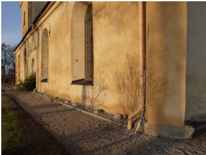
Figur 15. Södra väggen efter åtgärder. Foto: Helén Sjökvist.
