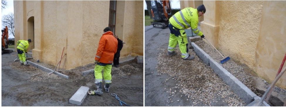
Figur 13. Sättning av kantsten. Foto: Helén Sjökvist.
