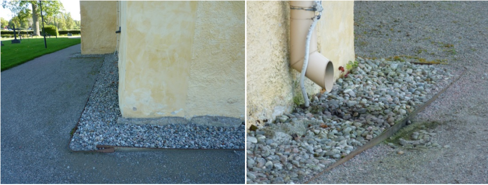
Figur 8. Järnkanten mellan singeldike och gången före åtgärder. Foto: Helén Sjökvist.
