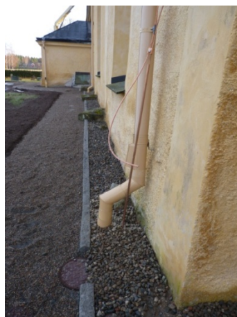
Figur 17. På korets norra sida fick stupröret anpassas efter grundens kraftigt utskjutande stenar under mark. Foto: Helén Sjökvist.
