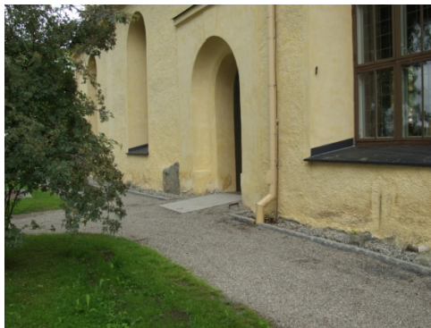
Figur 26. Ny ramp till södra entrén. Foto: Lisa Skanser.
