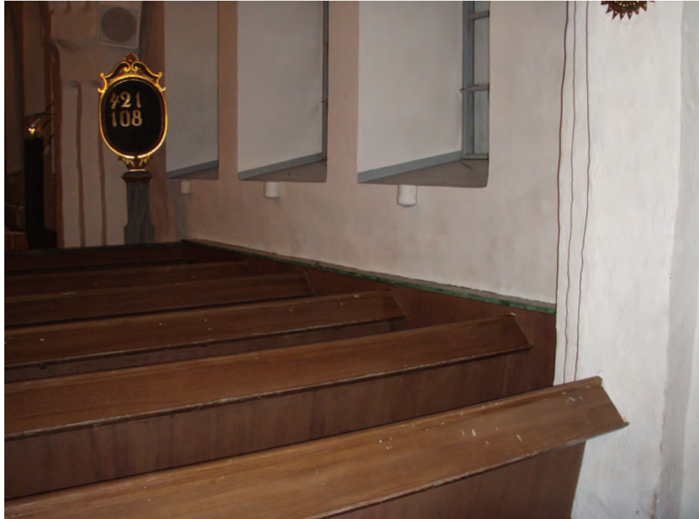
Figur 12. Södra bänkkvarteret efter åtgärder. Foto: Helén Sjökvist.
