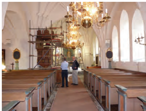
Figur 4. Kyrkan under pågående arbete. Foto: Boel Melin.
