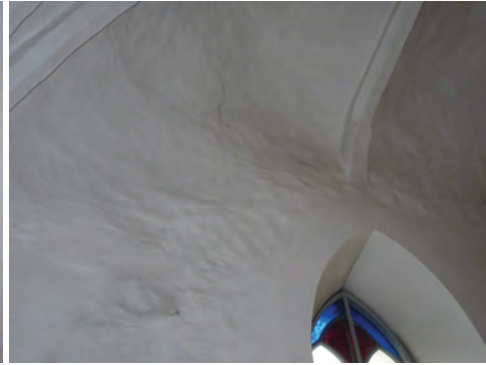
Figur 6. Fläckar på pelare i norra korsarmen. Foto: Boel Melin.
