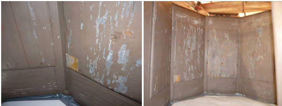
Figur 14. Den lilla fyrkanten är en framskrapad yta med oljespackel. Bilden visar även det äldsta gråblå färgskiktet där den bruna oljefärgen har flaggat och skrapats bort. Foto: Boel Melin.
