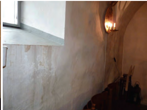
Figur 8. Rinningar och skadad puts under fönster. Foto: Boel Melin.
