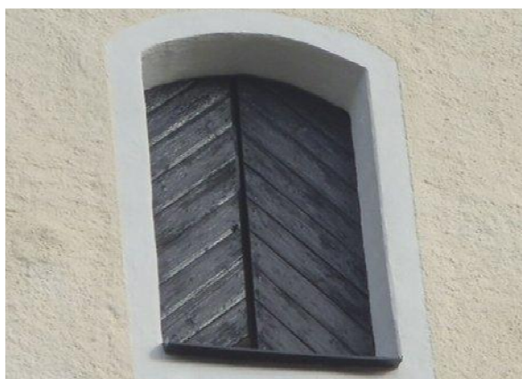
KLM11048 Irsta ka 20111020-197. Ljudlucka efter tjärning. Foto: Boel Melin.
