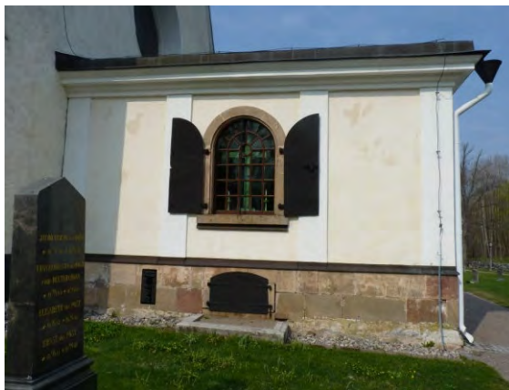
KM11048 Irsta ka 20110426-24. Västra gravkorets södra fasad innan åtgärder. Foto: Boel Melin.
