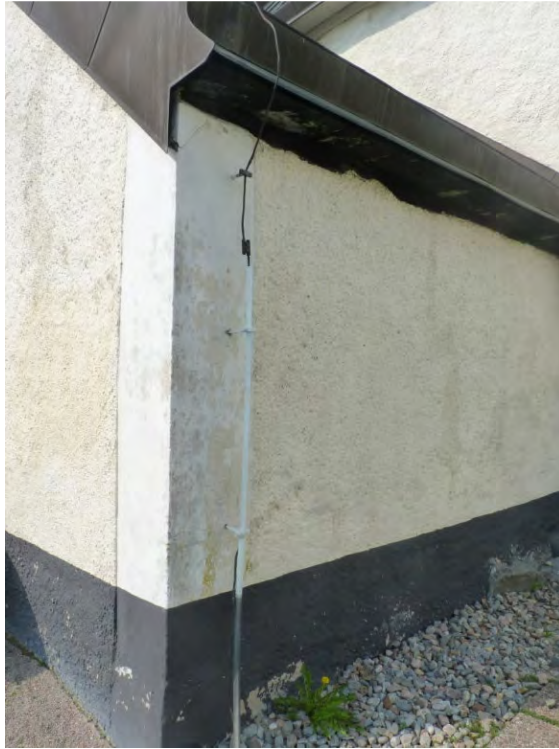
KM11048 Irsta ka 20110426-11. Våpenhusets sydvästra hörn innan åtgärder. Foto: Boel Melin.
