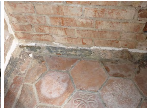
T.v. KM11048 Irsta ka 20110426-87. Putsbortfall inne i stigluckan, västra nedre väggen. Foto: Boel Melin. T.b. KM11048 Irsta ka 20110426-14. Kraftigt putsbortfall på östra nedre väggen. Foto: Boel Melin.
