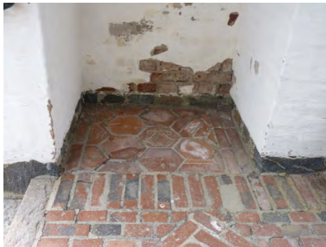
T.v. KM11048 Irsta ka 20110426-87. Putsbortfall inne i stigluckan, västra nedre väggen. Foto: Boel Melin. T.b. KM11048 Irsta ka 20110426-14. Kraftigt putsbortfall på östra nedre väggen. Foto: Boel Melin.
