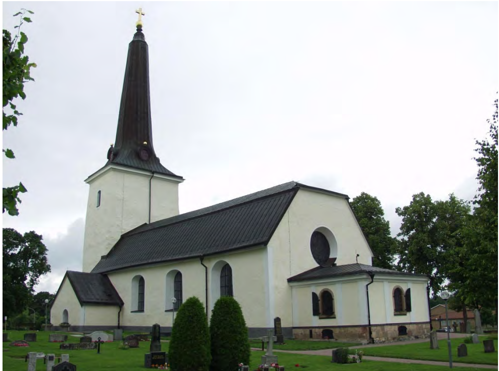
KM11048 Irsta ka 20120710-141. Kyrkan efter renovering. Foto: Lisa Skanser.
