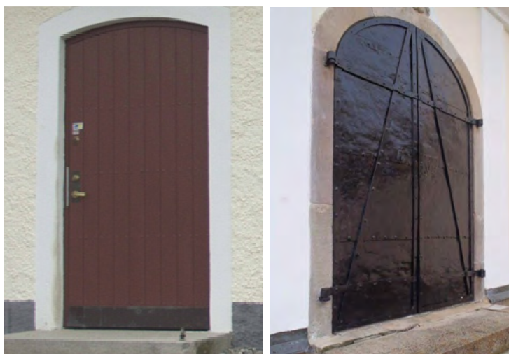
T.v. KM11124 Irsta ka 20120710-7. Sakristians östra dörr efter åtgärd. Foto: Lisa Skanser.
