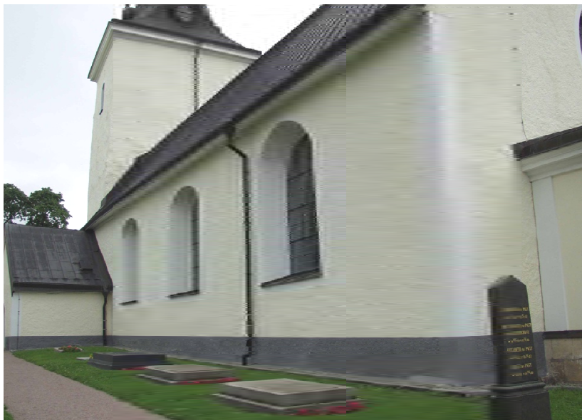
KM11048 Irsta ka 20120710-133. Långhusets södra fasad efter genomförda putsläggningar och avfärgning. Foto: Lisa Skanser.
