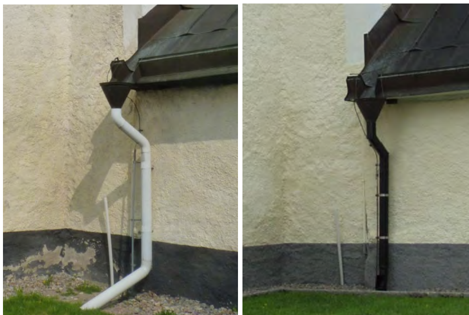
T.v. KM11048 Irsta ka 20110426-12. Stuprör Irsta ka vid vapenbusets västra hörn innan åtgärd. Foto: Boel Melin.
