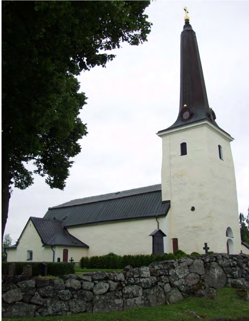
KM11048 Irsta ka 20120710-140. Kyrkan efter renovering. Foto: Lisa Skanser.
