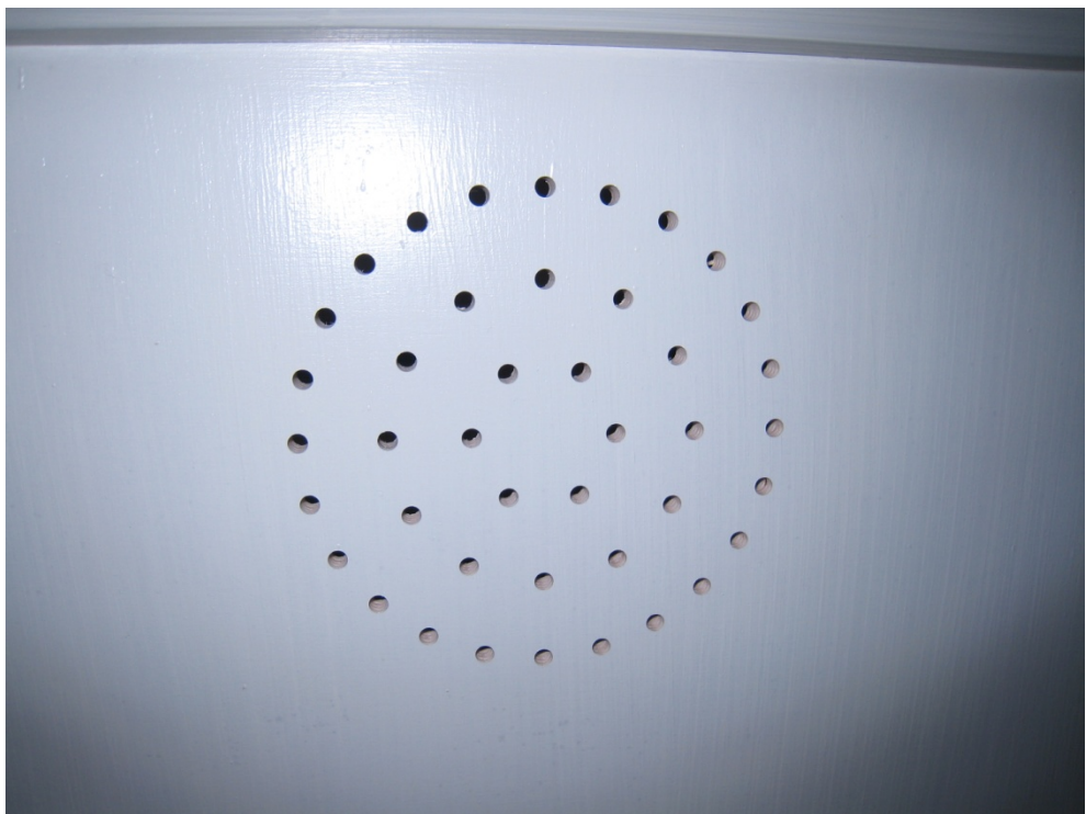
Figur 5. Ventilationshål. Foto: Helén Sjökvist.
