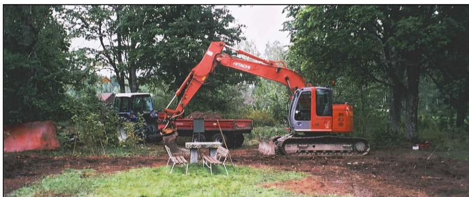
Figur 8. Rövning av stubbar efter kyrkans östra vägg. (Foto från väster, U. Alström.)
