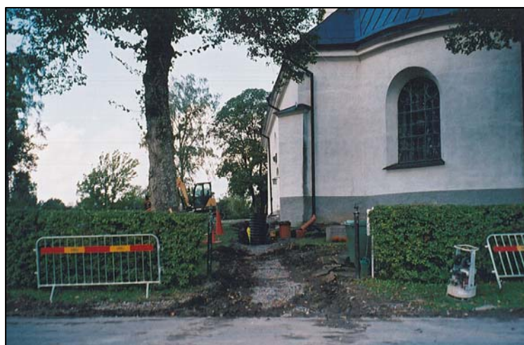
Figur 17. Schaktet i grusgången öster om kyrkan. (Foto mot väst U. Alström.)
