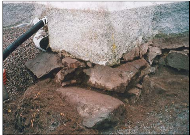
Figur 7. Grundstenarna under kyrkans norra strävpelare. (Foto U. Alström.)
