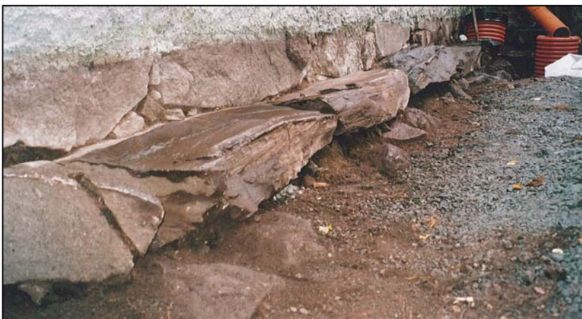
Figur 6. Kyrkans norra, mycket vällagda, grundmur vid korpartiet. (Foto U. Alström.)
