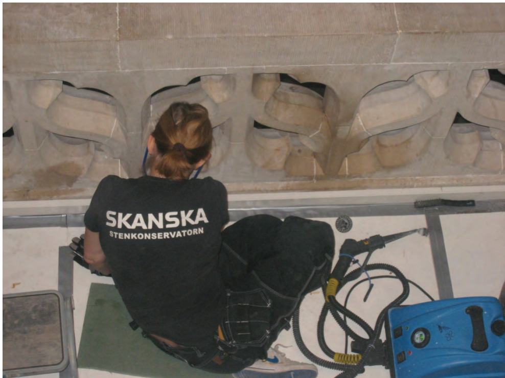
Figur 66. Pågående rengöring av balustraden med vattenånga. Foto: Helén Sjökvist.
