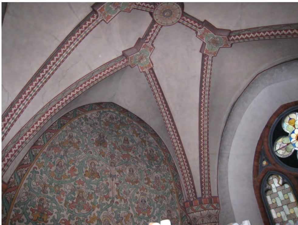
Figur 33. Tredje travén före rengöring. Foto: Helén Sjökvist.
