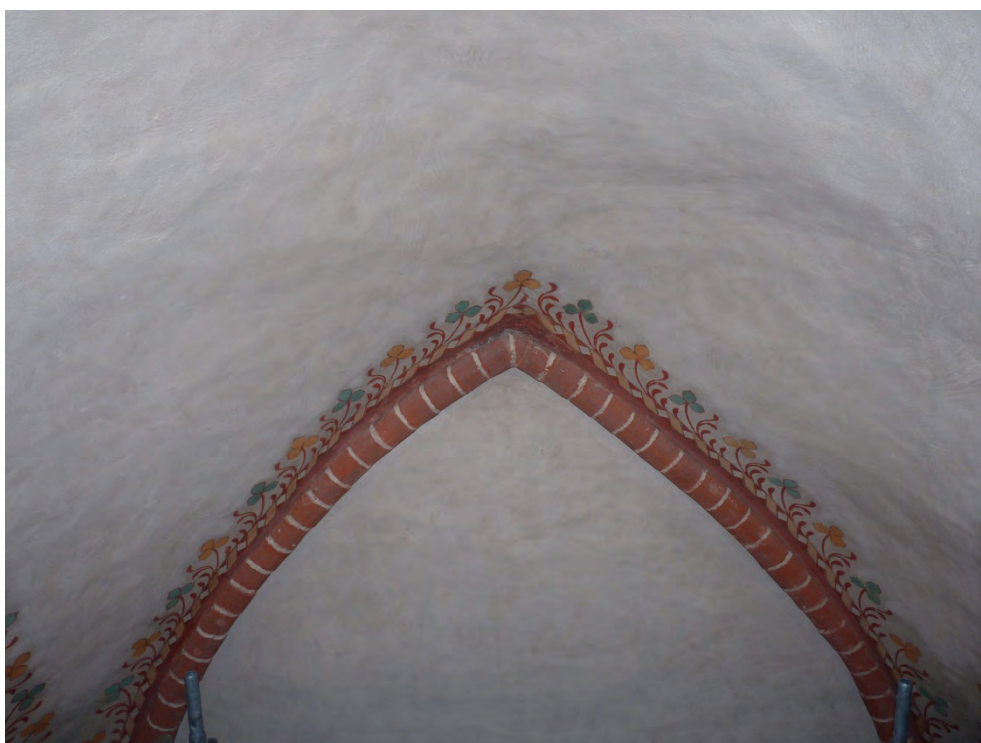
Figur 41. Vapenhusets valv efter lavering. Foto: Helén Sjökvist.
