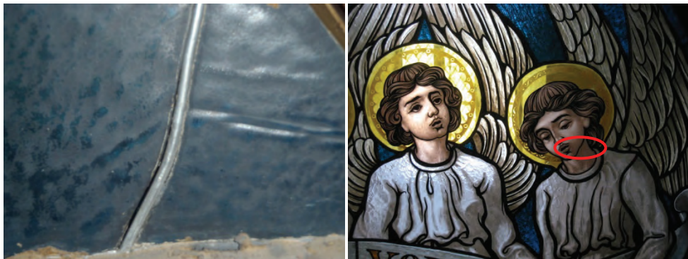
Figur 73. Blyinfattning som släppt. Foto: Helén Sjökvist.
