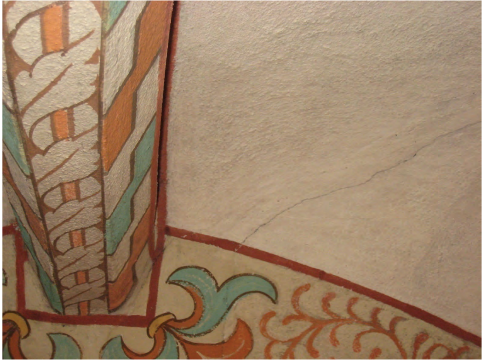
Figur 25. Spricka som senare lagades och retuscherades. Jämför fig. 26. Foto: Helén Sjökvist.
