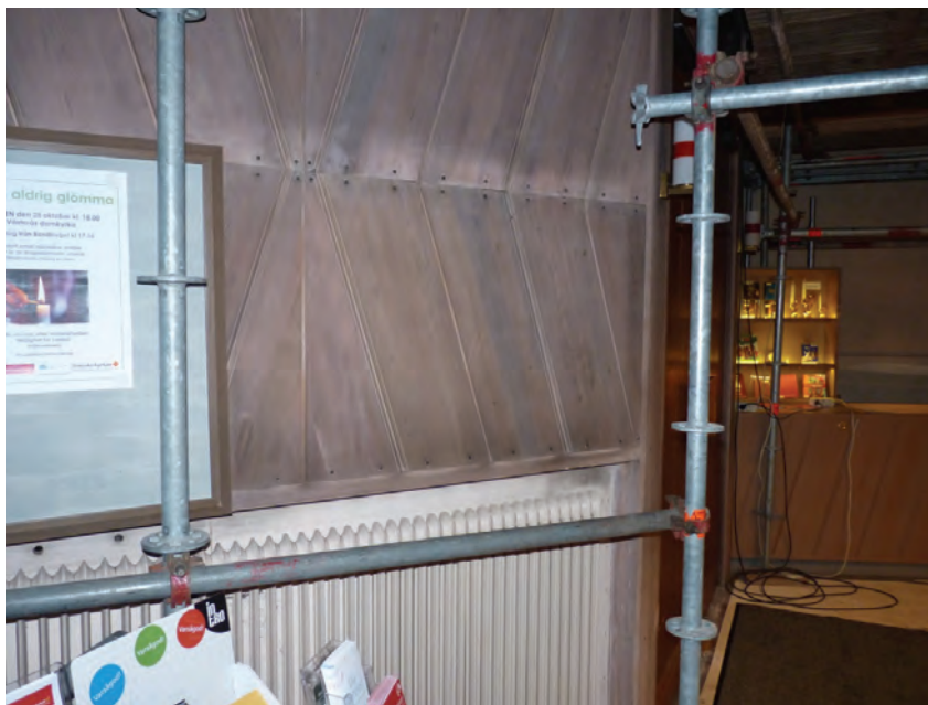
Figur 50. Entrépartiets träpanel har rengjorts med triammoniumcitrat. Foto: Helén Sjökvist.
