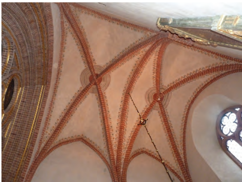
Figur 45. Vapenhusets valv efter rengöring. Foto: Helén Sjökvist.
