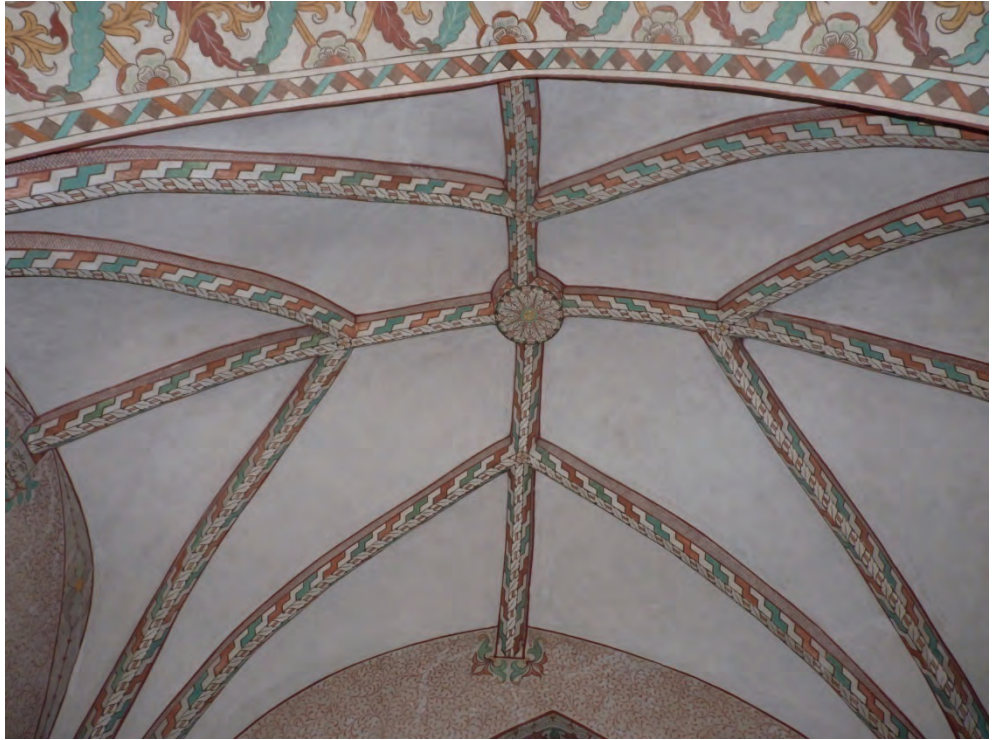
Figur 31. Andra travén efter rengöring. Foto: Helén Sjökvist.
