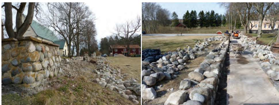
Figur 16. Södra muren sedd från sydväst. Muren är nedplockad till marknivå. Foto: Helén Sjökvist.
