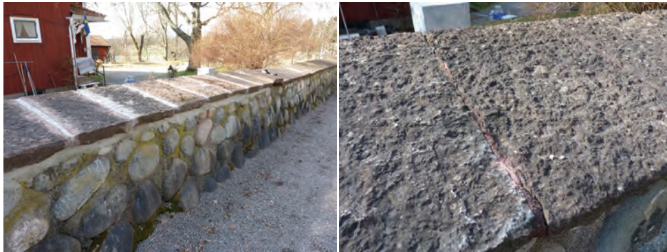
Figur 6. Södra muren hade under tidigare renoveringsetapp fått relativt ljusa och breda fogar mellan kalkstensplattor. Foto: Helén Sjökvist.
