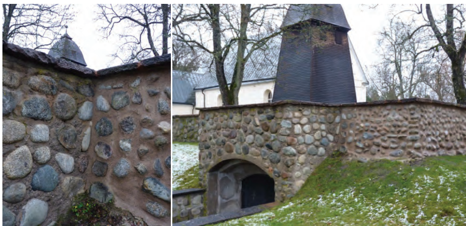
Figur 28. Anslutning mellan omgjord och äldre mur i nordvästra hörnet av kyrkogården. Foto: Helén Sjökvist.
