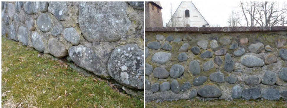
Figur 12. Gjuten betongsula under västra muren. Foto: Helén Sjökvist.
