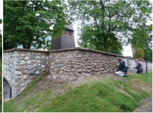
Figur 22. Sydvästra hörnet av muren färdigomlagd. Foto: Helén Sjökvist.
