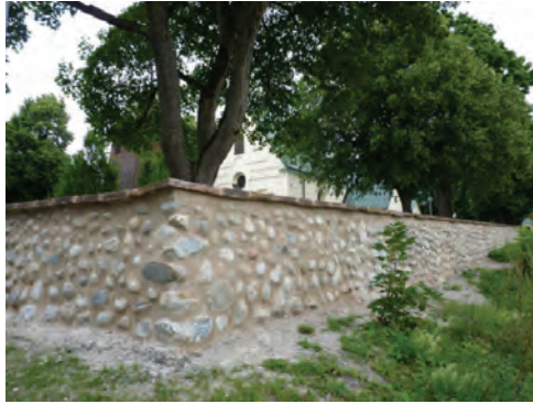
Figur 22. Sydvästra hörnet av muren färdigomlagd. Foto: Helén Sjökvist.
