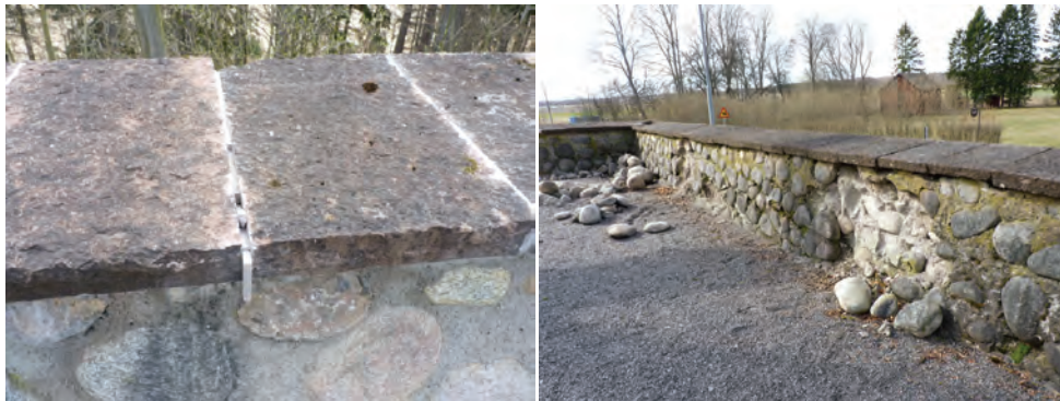
Figur 8. Norra muren med lite tunnare fogar mellan stenplattorna. Resultatet blir inte lika framträdande fogar. Problem tycks dock finnas med att materialet i fogarna kan spricka vilket ger risk för vatteninträngning i murarna och därefter kalkutfällningar eller på sikt urlakning av bruket i muren. Foto: Helén Sjökvist.
