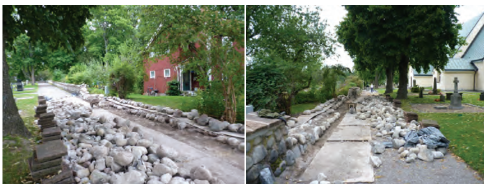
Figur 20. Södra muren nedplockad, sedd mot öster. Foto: Helén Sjökvist.
