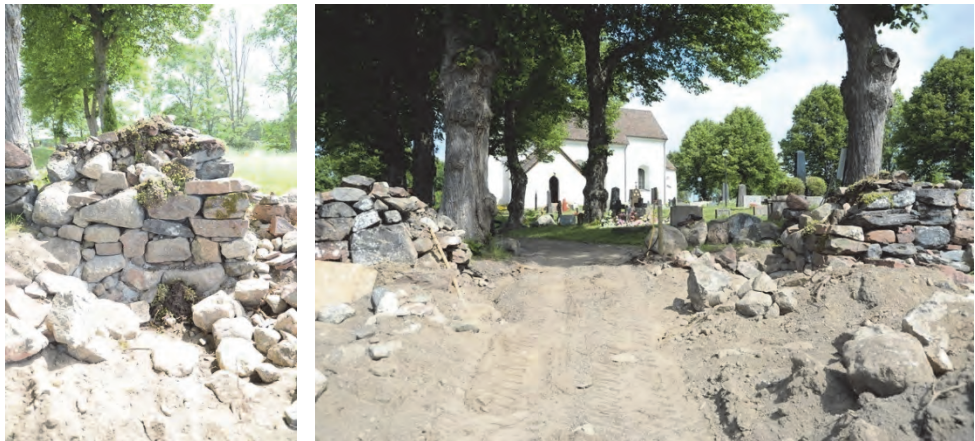
Figur 40. Genombrottet i muren visade att det där det nya muranslutet planerats mot öster redan fanns någon form av stötfog där större stenar lagts i jämna skift. Foto: Gunilla Nilsson, Svensk klimatstyrning.
