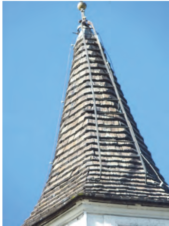
Figur 32. Åskeledare på tornet. Helén Sjökvist. Figur 33. Åskeledare monterat i spåntaket under lanterninen. Helén Sjökvist.
