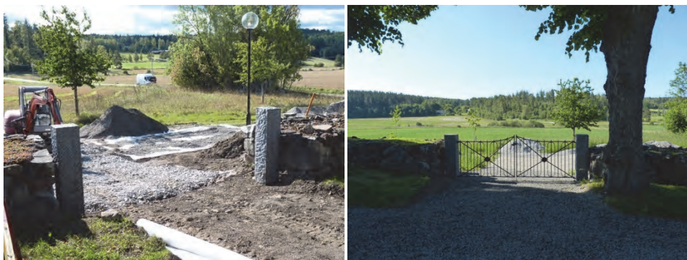
Figur 42. Murpartiet har tagits upp och nya grindstolpar av granit är på plats. Foto: Helén Sjökvist.
