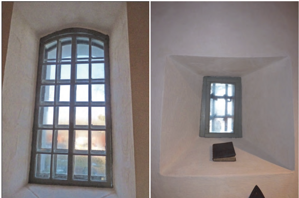
Figur 69. Norrfönster efter åtgärder. Foto: Helén Sjökvist.
