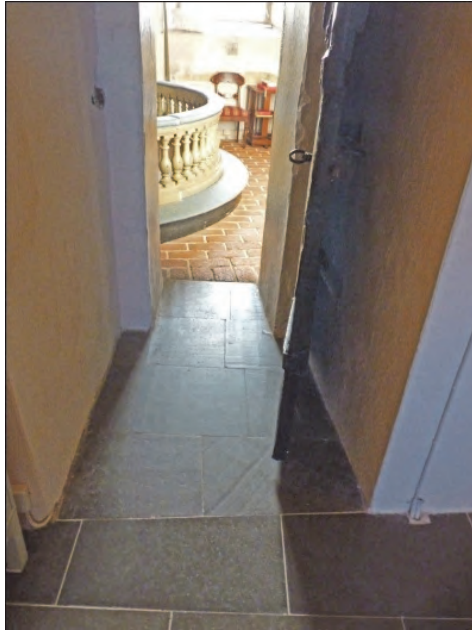
Figur 61. Nya kalkstensgolvet ansluter mot befintligt i passage till koret. Foto: Helén Sjökvist.
