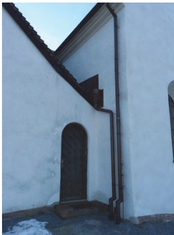
Figur 24. På grund av tidigare problem med missfärgningar och algpåväxt på putsen har tratten till stupröret i hörnet mellan sakristia och norra korsarmen förhöjts. Jämför figur 18. Foto: Helén Sjökvist.
