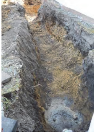
Figur 20. Grävning utmed sakristians östra mur. Foto: Svensk Klimatstyrning.
