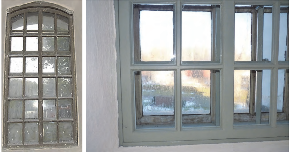
Figur 67. Norrfönster i sakristian före åtgärder. Foto: Svensk klimatstyrning.
