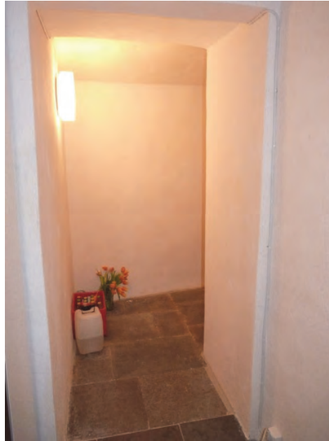
Figur 61. Nya kalkstensgolvet ansluter mot befintligt i passage till koret. Foto: Helén Sjökvist.
