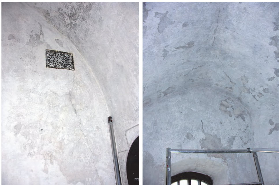
Figur 53. Rengöring av väggar och valv i sakristians sydvästra hörn. Foto: Svensk Klimatstyrning.
