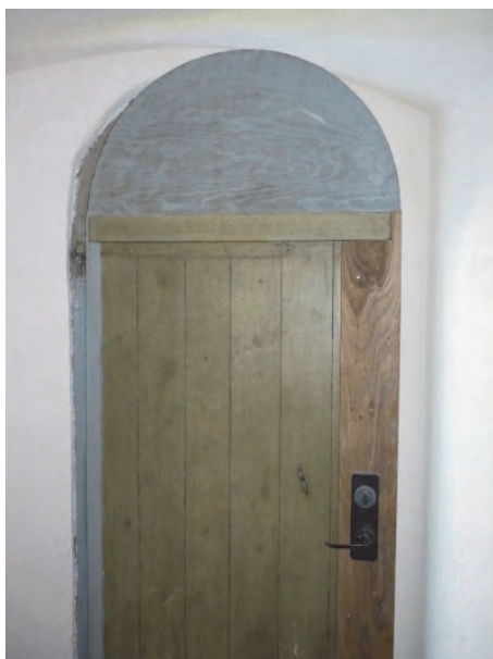
Figur 71. Norra sakristiedörren sedd från vindfånget. Plywoodsskivan i övre delen har troligen satts på för att tätä dörren något. Denna skiva har nu kapats lite i överkant för att dörren skall gå att ställa upp ordentligt. Foto: Helén Sjökvist.
