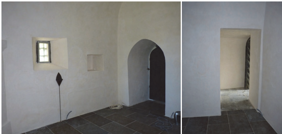
Figur 59. Sakristian med nytt kalkstensgolv och färdigstrukna väggar sett mot sydöst. Helén Sjökvist.
