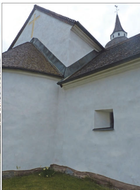
Figur 18. Sakristians norra vägg före åtgärder. Observera också problematiken med omfattande algbildning på väggen vid stuprör i anslutningen mellan sakristian och norra korsarmen. Foto: Helén Sjökvist.
