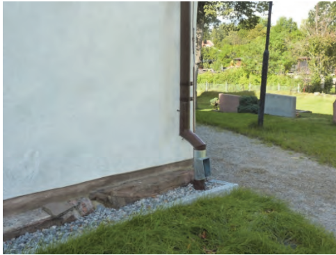
Figur 22. Sakristians östra vägg efter åtgärder. En stenkant avgränsar det dränerande singelpartiet invid grundmuren. Stuprören är direktkopplade till ett nedgrävt vattenavledningssystem. Lövsilarna har senare målats in i samma kulör som stuprören. Foto: Helén Sjökvist.
