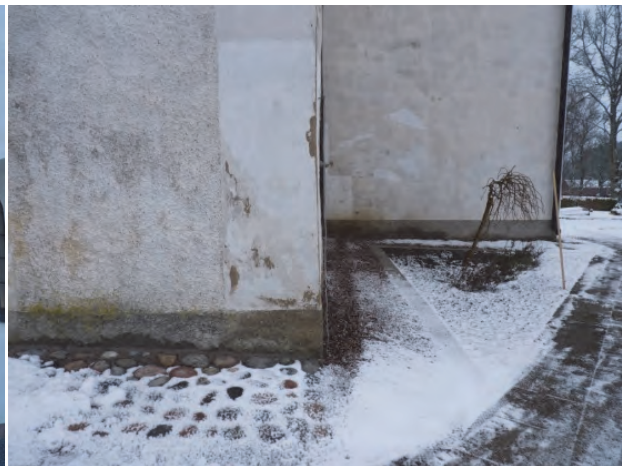
Figur 24. På grund av tidigare problem med missfärgningar och algpåväxt på putsen har tratten till stupröret i hörnet mellan sakristia och norra korsarmen förhöjts. Jämför figur 18. Foto: Helén Sjökvist.
