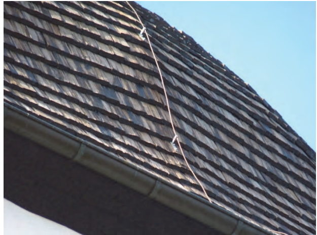
Figur 32. Åskeledare på tornet. Helén Sjökvist. Figur 33. Åskeledare monterat i spåntaket under lanterninen. Helén Sjökvist.
