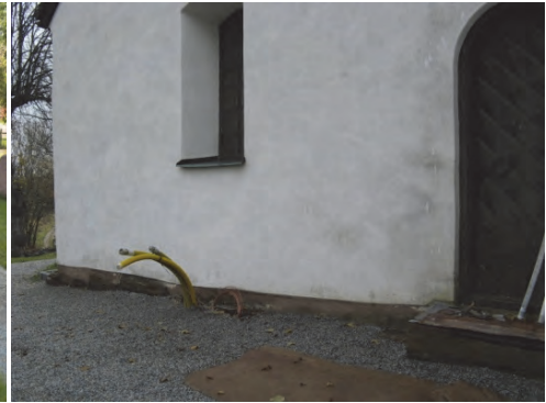
Figur 22. Sakristians östra vägg efter åtgärder. En stenkant avgränsar det dränerande singelpartiet invid grundmuren. Stuprören är direktkopplade till ett nedgrävt vattenavledningssystem. Lövsilarna har senare målats in i samma kulör som stuprören. Foto: Helén Sjökvist.
