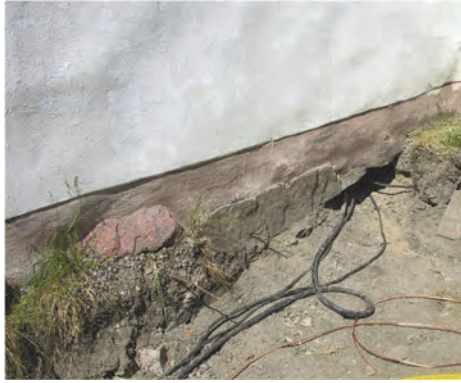
Figur 30. Anslutning för åskskydd i tornets södra mur. Foto: Svensk Klimatstyrning. Figur 31. Ny åskeledare monterad på södra vapenhuset. Helén Sjökvist.
