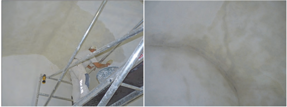
Figur 55. Kalkavfärgning, tredje strykningen. Helén Sjökvist.
