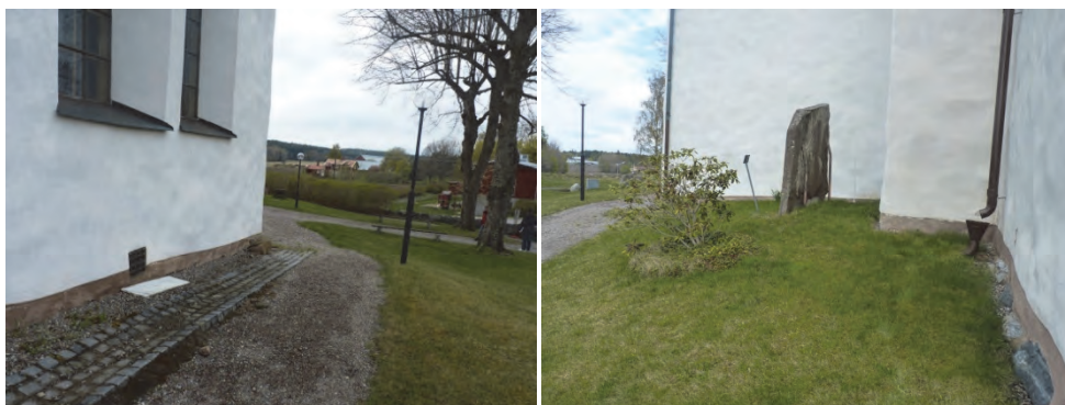
Figur 14. Norra korsarmens norra fasad med gatstensbeläggning, före åtgärder. foto: Boel Melin.
