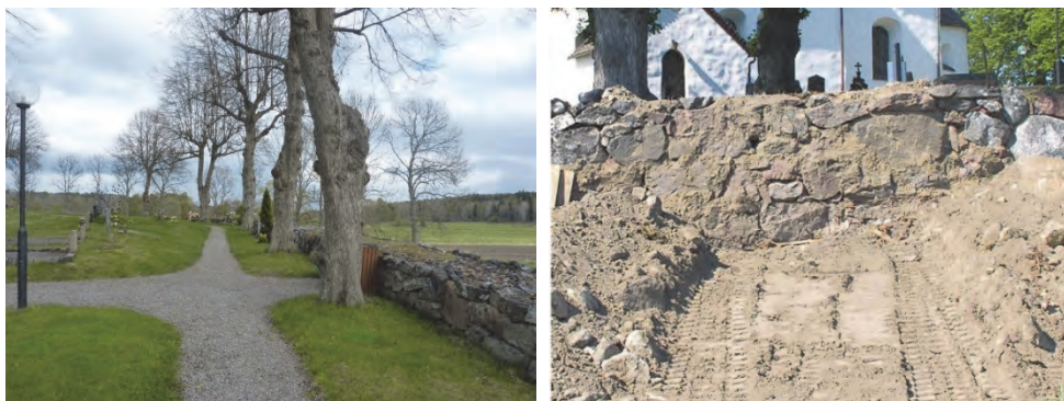
Figur 37. Södra muren sedd mot öster. Där gången mot söder slutar togs den nya öppningen i muren upp. Foto: Helén Sjökvist.
