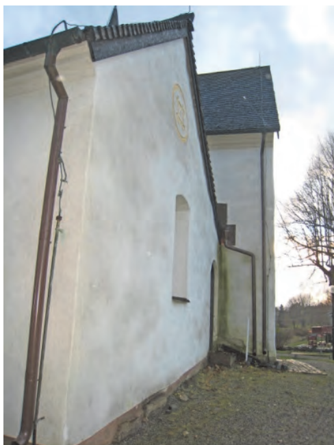
Figur 18. Sakristians norra vägg före åtgärder. Observera också problematiken med omfattande algbildning på väggen vid stuprör i anslutningen mellan sakristian och norra korsarmen. Foto: Helén Sjökvist.
