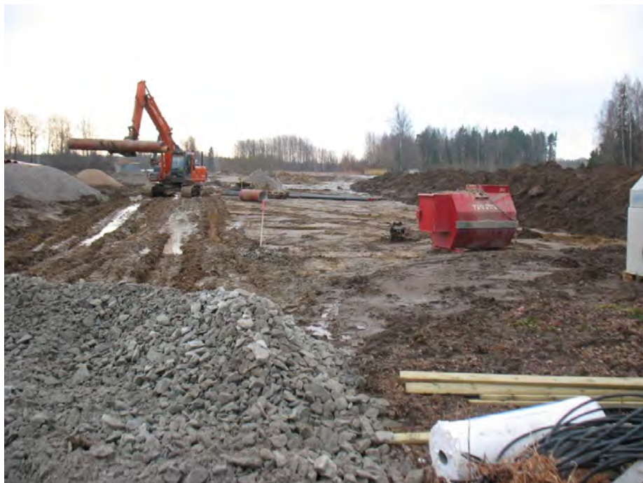
Figur 4. Undersökningsområdets norra del, där den släta ytan motsvarar schakt 1. Foto från norr, Jenny Holm.
