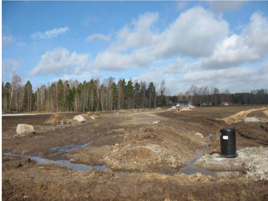
Figur 3. Boplatsen Örebro 415 med VA-ledningen nedlagd diagonalt över fornlämningen, dumphögar till vänster och körspår till höger. Foto från sydsydöst, Jenny Holm.
