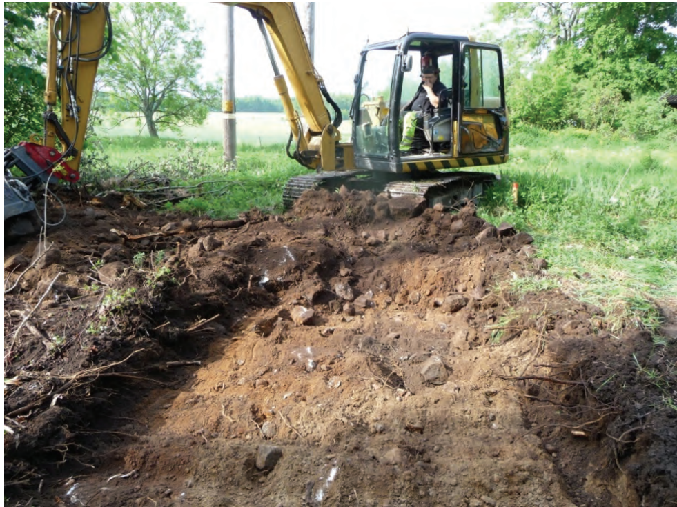
Figur 6. Schakt 1. Morän under modernt stenlager. Foto från nordöst Ellinor Larsson.
