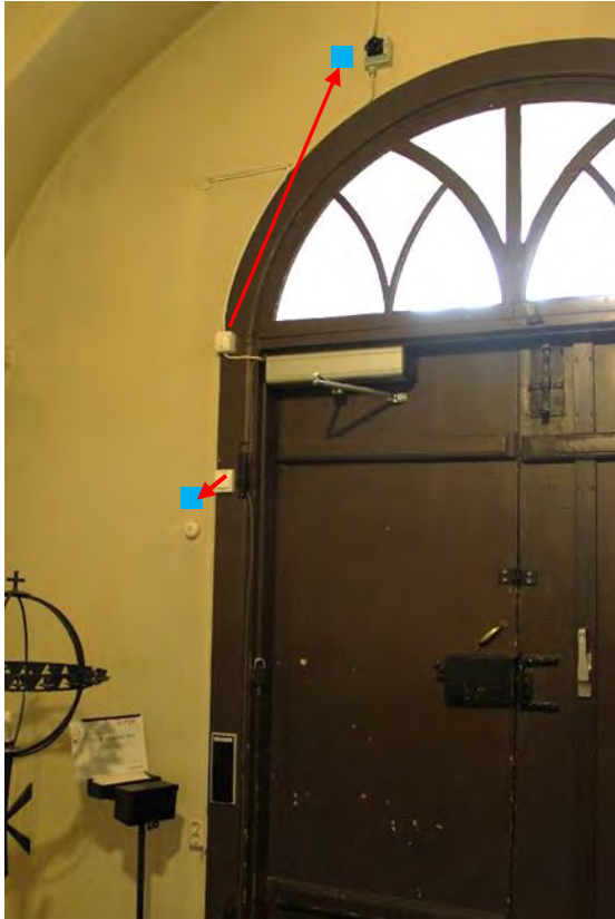
Strömbrytare som skall justeras. Kristina ka 20130416_0183.
