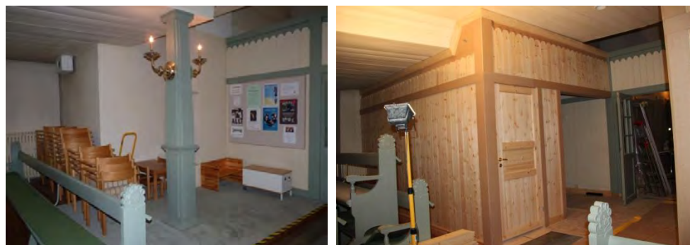
Bilden till vänster visar tidigare förvaringsutrymme under läktaren, på södra sidan av mittgången, i västra delen av långhuset. Pelaren byggdes in i det nya förrådet. KM12078 Kristina ka 20120619_5 av Helén Sjökvist. Bild till höger: Samma utrymme har byggts in med förråd och kapprum. Kristina ka 20121002_0074.
