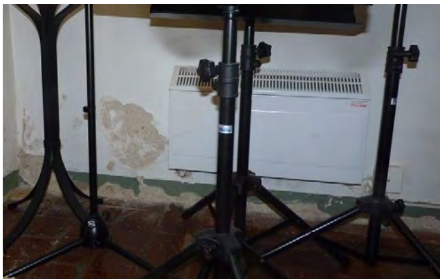
Bild till vänster visar väggyta mot öster innan åtgärd.
