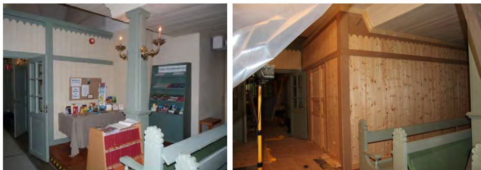
Bilden till vänster visar tidigare utrymme under läktaren, på norra sidan av mittgången, i västra delen av långhuset. Pelaren byggdes in i det nya förrådet. KM12078 Kristina ka 20120619_6 av Helén Sjökvist. Bild till höger: Samma utrymme har byggts in med förråd. Kristina ka 20121002_0073.
