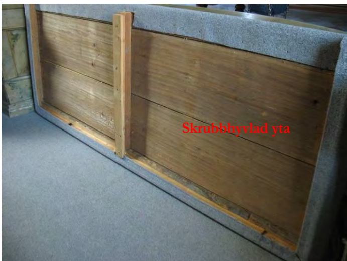
Övre steget på avsatsen framför altaret är gjort av två breda skrubbhylade brädor. Dessa har böj ålder och är troligen återanvända brädor. Ovansidan (dold av heltäckningsmatta) var slätthylad och
