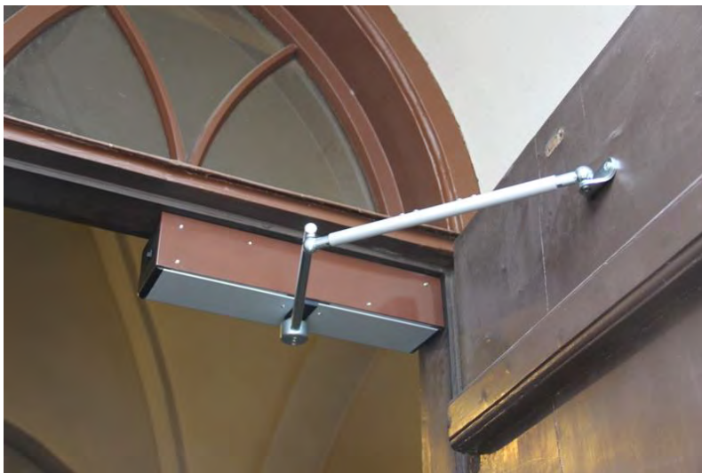
Ny dörrstängar/öppnaren är monterad i dörrkarmens överstycke och inklädd i brun plåt. Kristina ka 20130416_0190.
