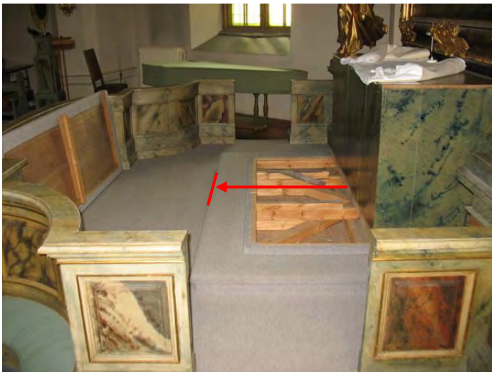
Altaret flyttades fram enligt pilen till röd markering. Foto: KM12078 Kristina ka 20120910_0018.
