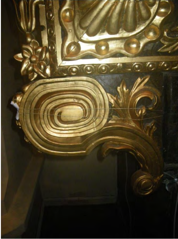
Figure 4 Skada efter restaurering.
