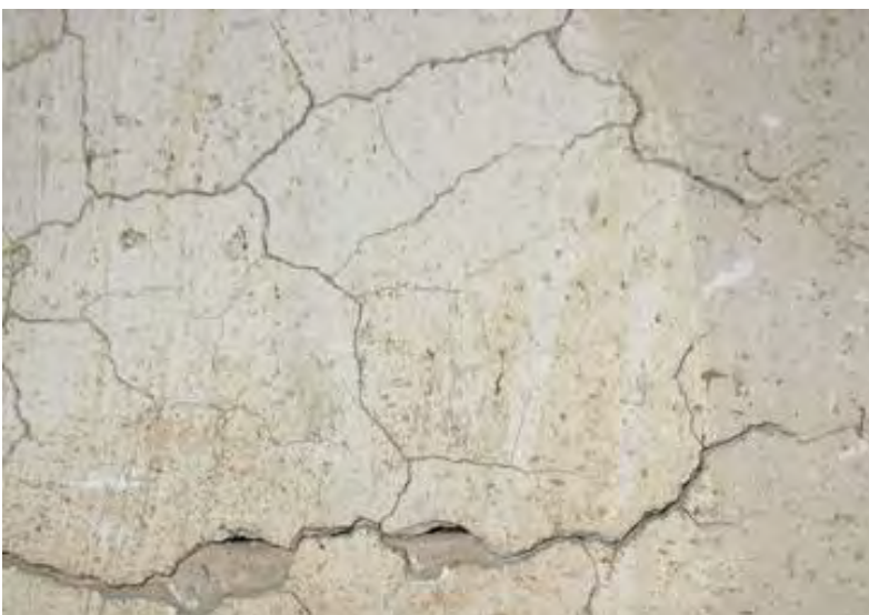
Kalkputsad yta på del av den murade konstruktionen innanför altaret. Foto: KM12078 Kristina ka 20120910_0008.
