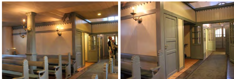
Bilderna visar nytt förråd och kapprum under läktaren, på södra sidan av mittgången, i västra delen av långhuset efter ombyggnation. Kristina ka 20121113_0130 och _0098.
