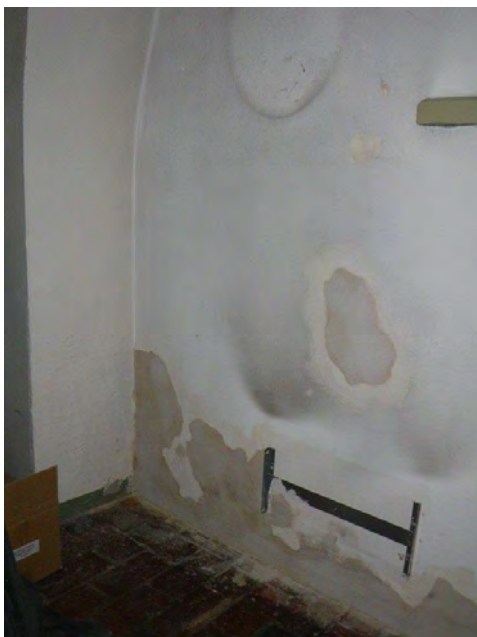
Bild till vänster visar väggyta mot öster efter putslagningar. Foto: IMG0085 av Teresia Strömgren.
