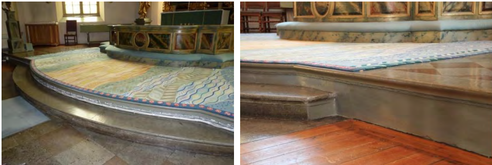
Bild till vänster visar vita elkablar dragna vid trappan till koret. Foto: KM12078 Kristina ka 20120619_16 av Helén Sjökvist. Bild till höger visar elkablar efter omdragning och intoning mot bakgrunden. Foto: Kristina ka 20121113_0141.
