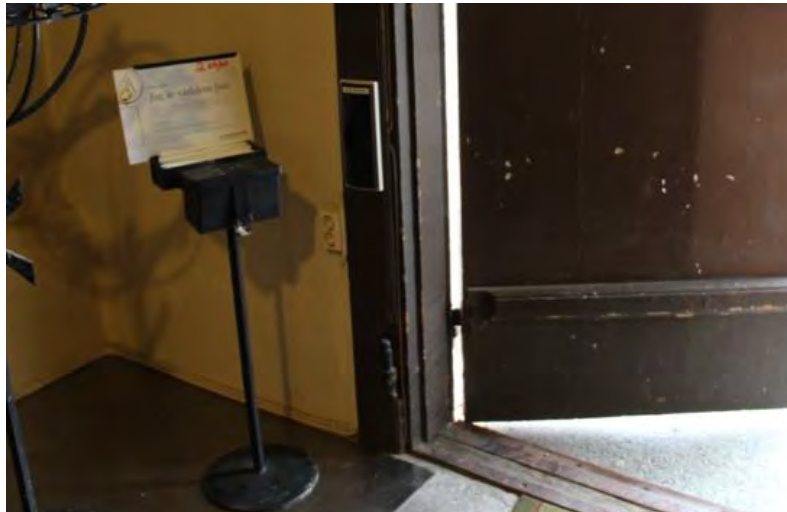
Dörrtryckare monterad på karmen. Nedtill där karmen möter tröskel, borrades hål genom karmen för dragnig av elkabel. Kristina ka 20130416_0191.
