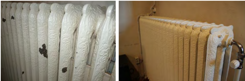
Bild till vänster: flagnande färg på radiator. Foto: KM12078 Kristina ka 20120619_8. Bild till höger: radiator efter målningsbehandling. Foto: Kristina ka 20121113_0109.
