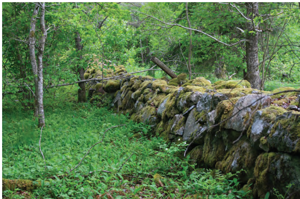
Figur 10. Del av stenmuren, objekt 25 och 29 - Österåker 117. Foto från sydväst, Jenny Holm.
