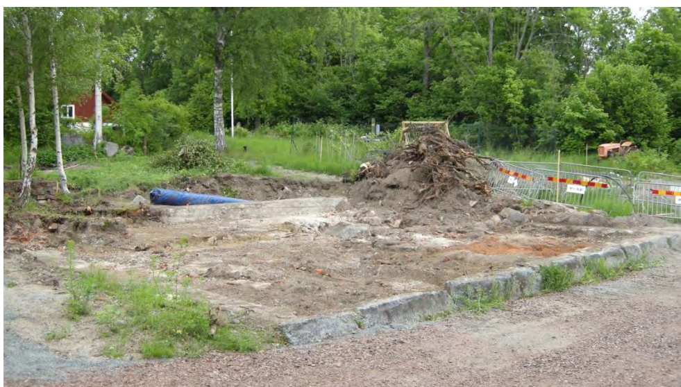
Figur 9. Den framschaktade busgrunden från sydväst. Den förhöjda grundmuren syns till vänster om dumphögen. Foto från sydväst av Christian Gatti.
