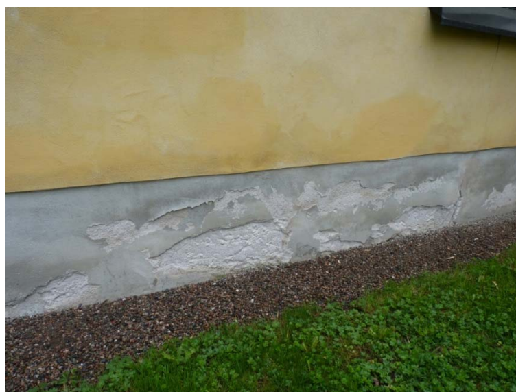
Figur 16. Sockeln uppvisar putsläpp, lagningar och dåligt fäste för anfärgningen. Till höger i bild syns även en spricka som löper från mark upp till fönsteröppningens undre del. Foto: Tobias Mårud.
