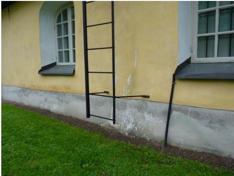
Figur 13. Samma område efter putsläggningar. Foto: Tobias Mårud.
