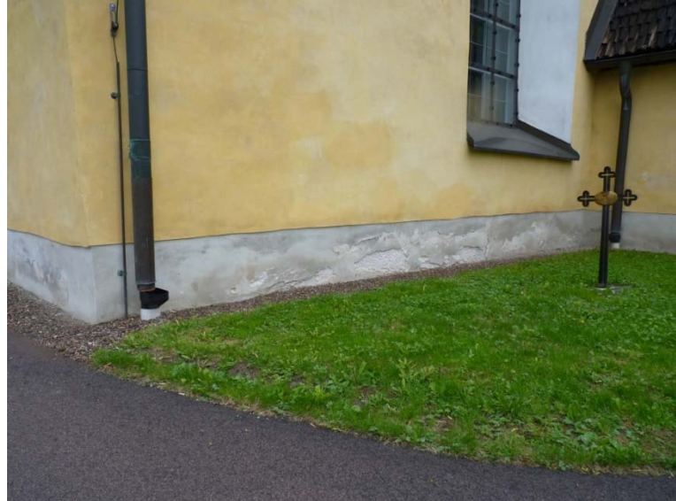
Figur 16. Sockeln uppvisar putsläpp, lagningar och dåligt fäste för anfärgningen. Till höger i bild syns även en spricka som löper från mark upp till fönsteröppningens undre del. Foto: Tobias Mårud.
