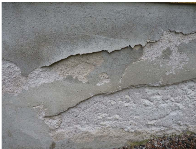
Figur 7. Sockelns avfärgning hade delvis släppt från putsen. Foto: Tobias Mårud.
