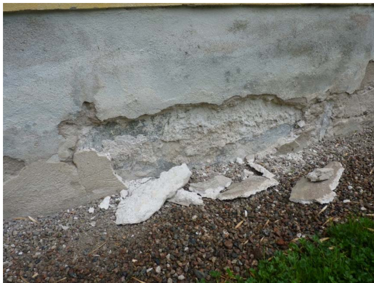
Figur 6. Här syns även att fukten har transporterats upp i väggputs. Foto: Tobias Mårud.
