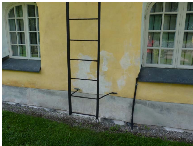
Figur 13. Samma område efter putsläggningar. Foto: Tobias Mårud.
