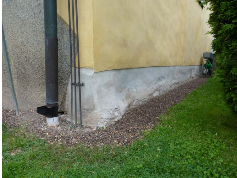
Figur 9. Sydöstra hörnet efter renovering, men innan anfärgning. Sockelns puts är bortbuggen i nederkant. Foto: Tobias Mårud.
