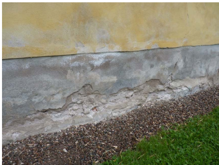
Figur 7. Sockelns avfärgning hade delvis släppt från putsen. Foto: Tobias Mårud.
