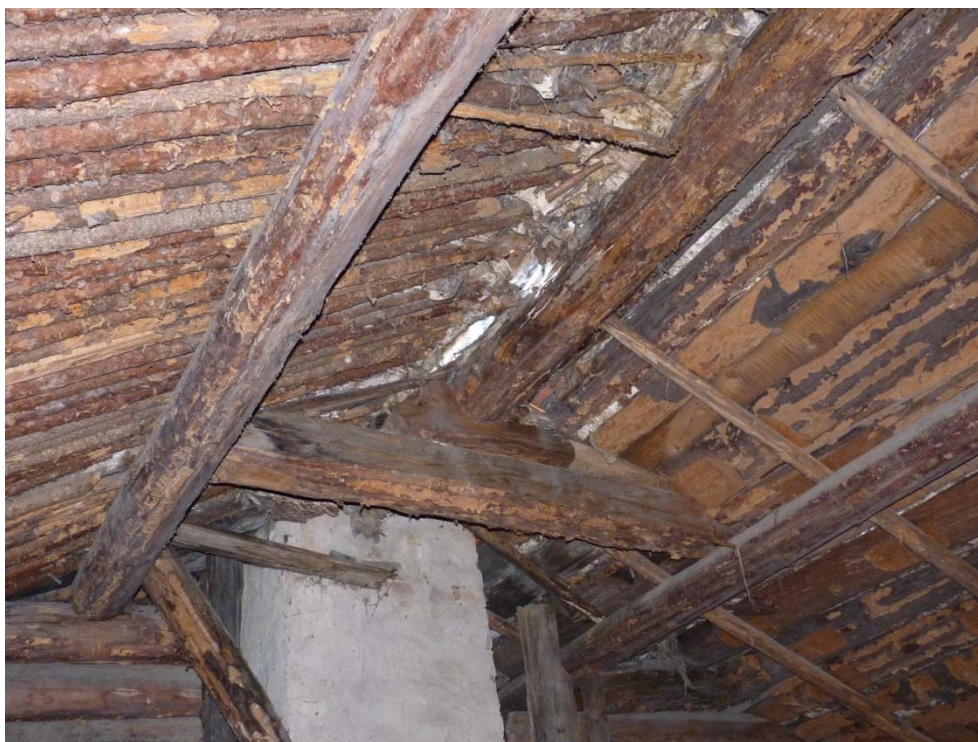
Figur 17. Takkonstruktion mednockås och sidoåsar. Foto: Helén Sjökvist.
