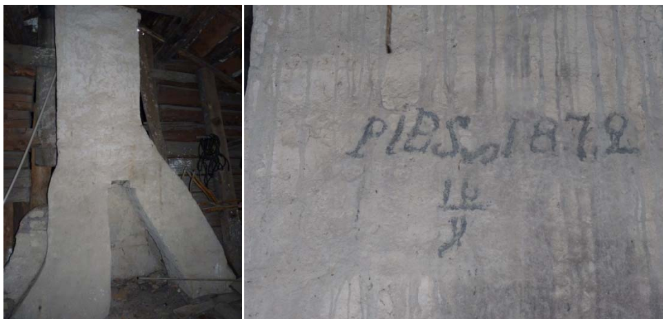
Figur 18. Skorstensstock med flera kanaler. Foto: Helén Sjökvist.
