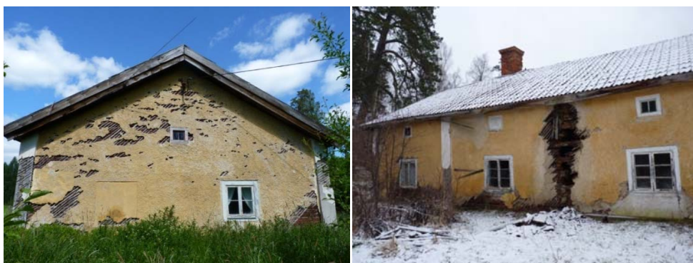
Figur 35. Troligen tjärade vindskivor. Foto: Helén Sjökvist.
