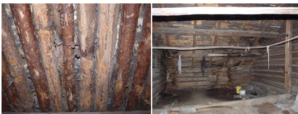
Figur 15. Östra takfallets undertak sett från vinden. Tätt liggande, smala, obarkade sparrar eller raftor där det överliggande näverlagret ans i gliporna. Foto: Helén Sjökvist.
