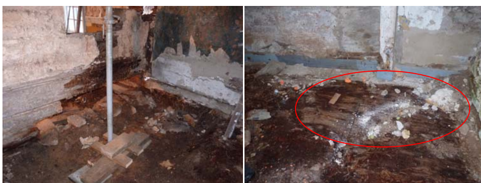
Figur 45. Borttagen del av mellanvägg sedd från rummet norr om svampangreppet. Foto: Helén Sjökvist.
