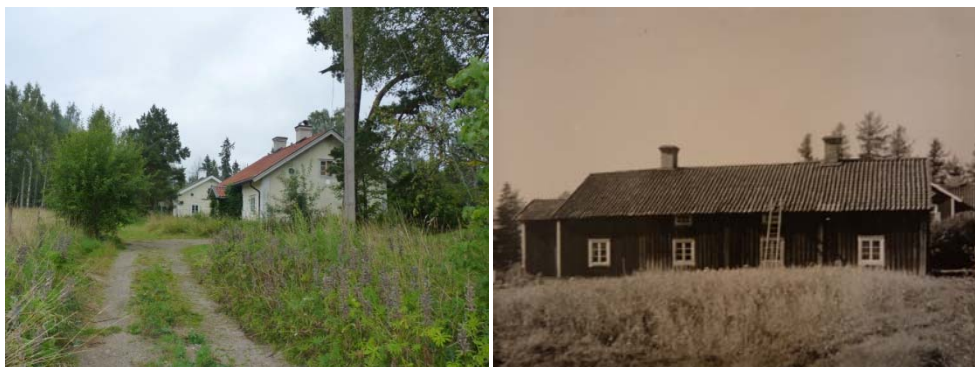
Figur 6. Direkt norr om den aktuella byggnaden ligger ytterligare två tidigare arbetarbostäder. Foto: Helén Sjökvist.
