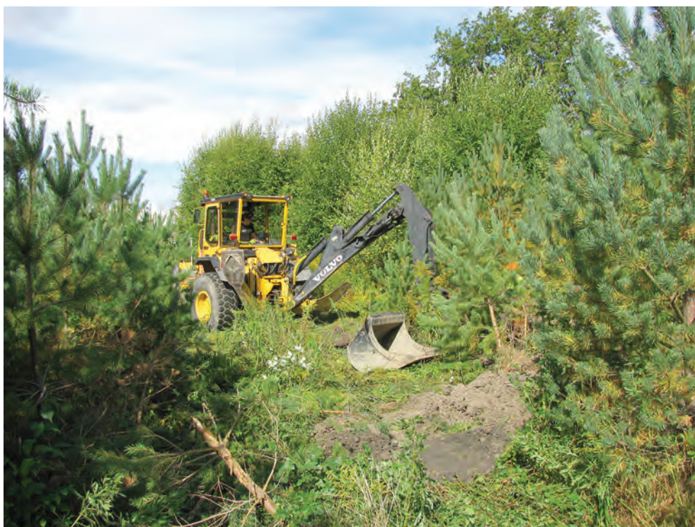
Figur 7. Schaktning inom det östra området, den påträffade boplatsen Fanna 06. Vegetationen på den f.d. åkern var mestadels besvärlig i relation till schaktningsbehovet. Foto från söder, Ronnie Jensen.
