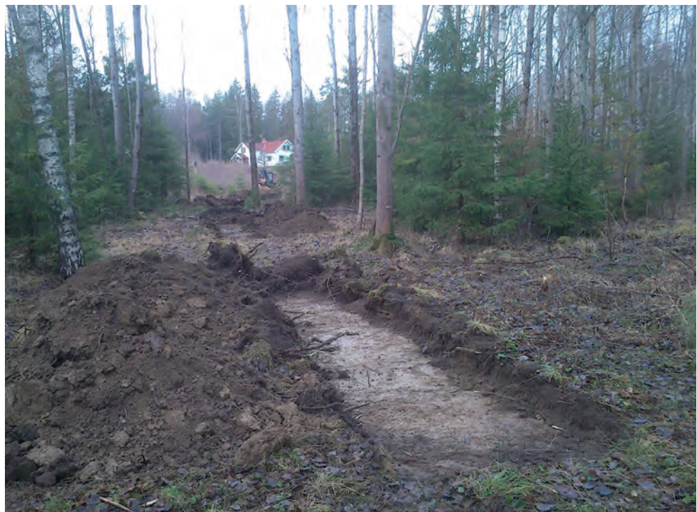
Figur 5. Arbetsbild med sökschakt 4 i förgrunden. Fotograferat från sydost av Maud Emanuelsson.
