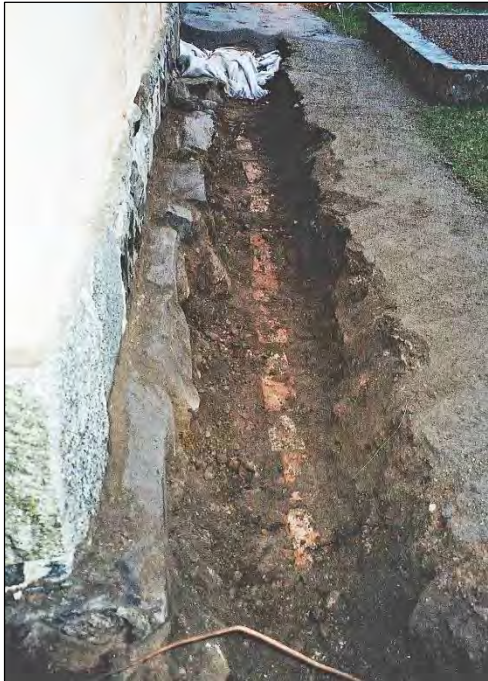
Figur 5. Schaktet vid salkyrkans (korets) östra grundmur. Under tegelmarkeringen låg en kabel. Närmast i bild syns även den obligatoriska åskledaren. (Foto från syd U. Alström.)
